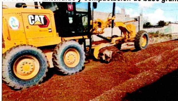
Ilustración 6 - Extendido y compactación de base granular
