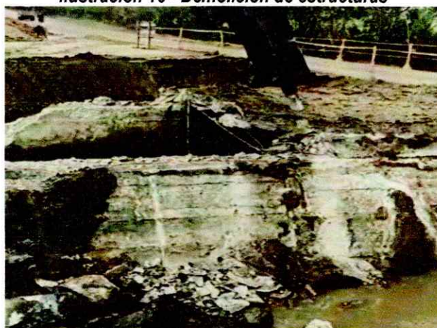
Ilustración 16 - Demolición de estructuras
