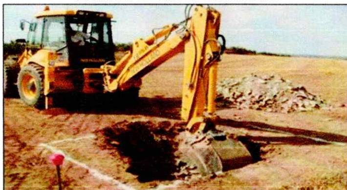
Ilustración 10 - Excavación mecánica
