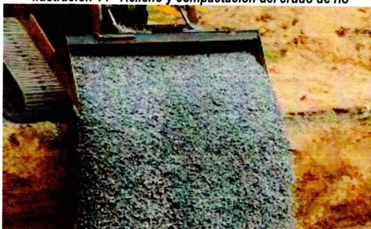
Ilustración 14 - Relleno y compactación del crudo de río
