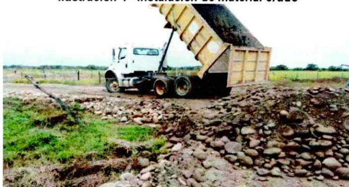
Ilustración 4 - Instalación de material crudo
