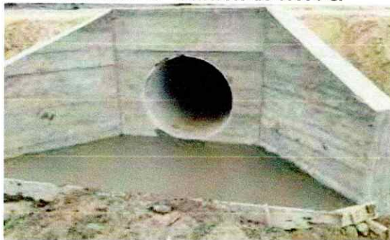
Ilustración 13 - Concreto de 4000 PSI
