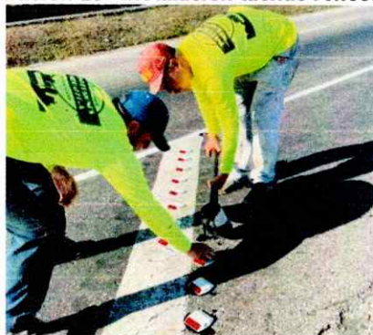
Ilustración 29 - Instalación tachas reflectivas
