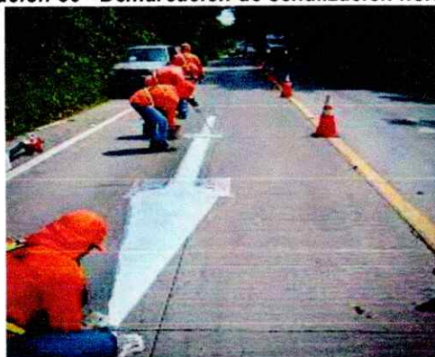
Ilustración 30 - Demarcación de señalización horizontal
