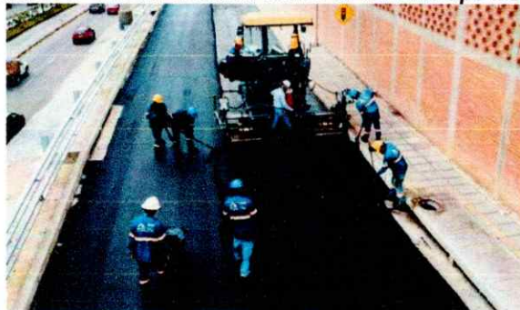
Ilustración 8 - Mezcla asfáltica densa en caliente tipo MDC - 19
