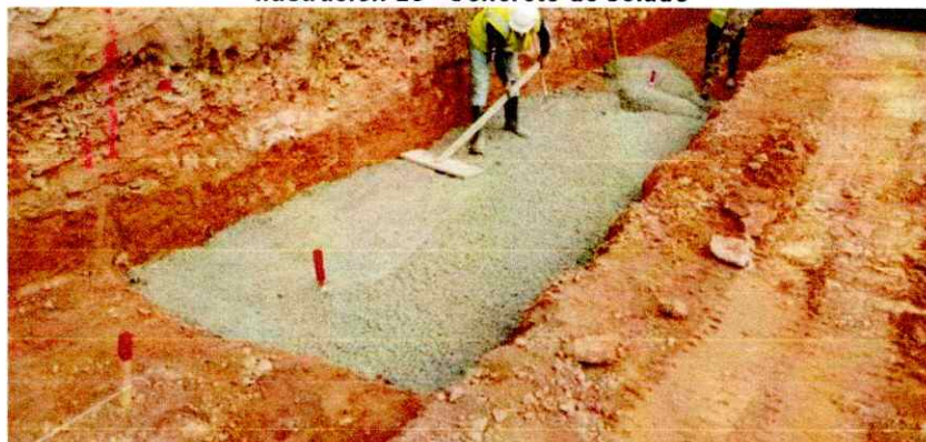
Ilustración 25 - Concreto de solado
