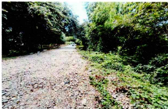
ESTRUCTURA HIDRÁULICA EXISTENTE
