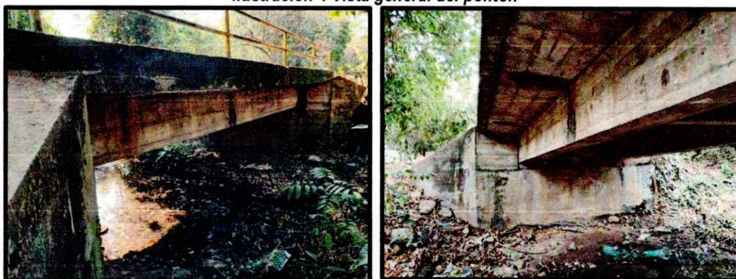
Ilustración 4 Vista general del pontón
