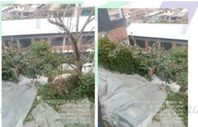
Figuras 6 y 7: Disposición de materiales y adecuaciones sobre la parte superior de la ladera en predios colindantes.
