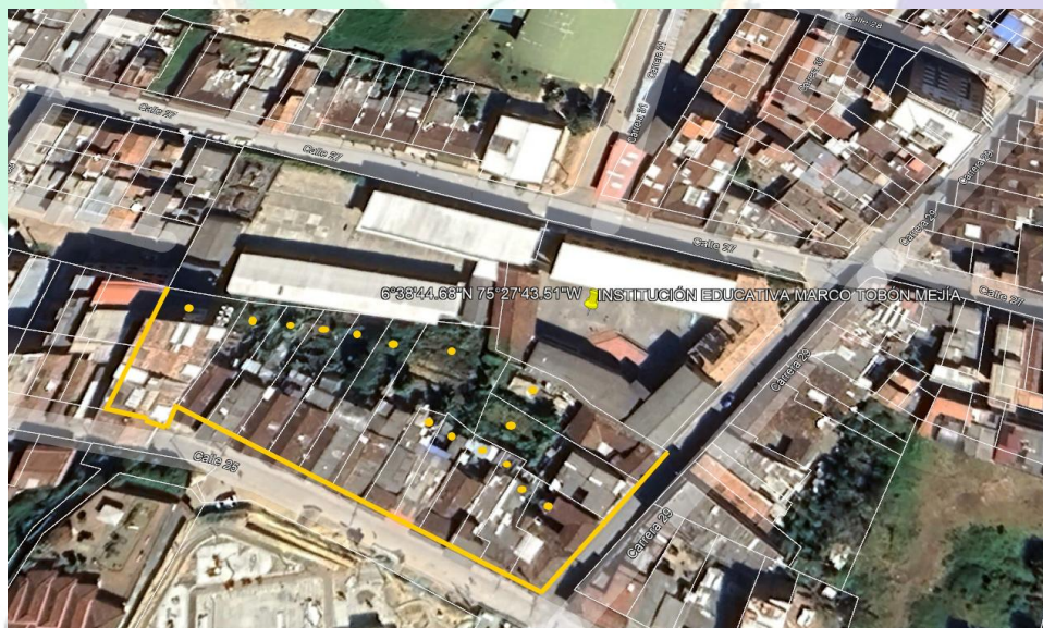
Figura 2. Ubicación general de la ladera posterior de la Institución Educativa Marco Tobón Mejía y de los predios residenciales colindantes localizados en la parte superior del talud.
