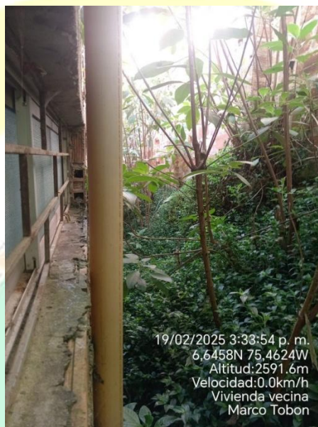
Figura 5: Cobertura vegetal abundante y condiciones de humedad permanente sobre la ladera colindante con la Institución Educativa Marco Tobón Mejía.
