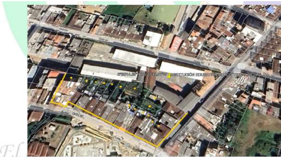
Figura 2. Ubicación general de la ladera posterior de la Institución Educativa Marco Tobón Mejía y de los predios residenciales colindantes localizados en la parte superior del talud.
