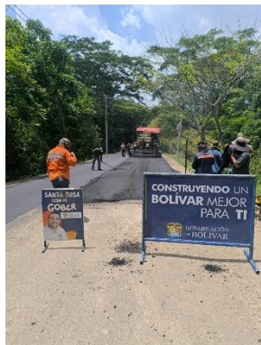
Extensión y compactación de mezcla asfáltica
