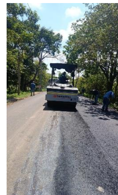
Extensión y compactación de mezcla asfáltica
