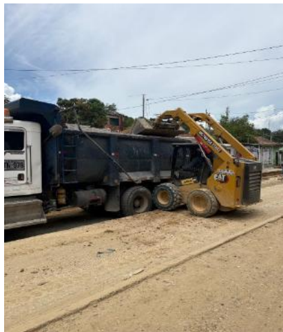
Transporte de materiales provenientes de excavaciones
