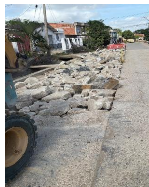
Demolición de pavimento rígido
