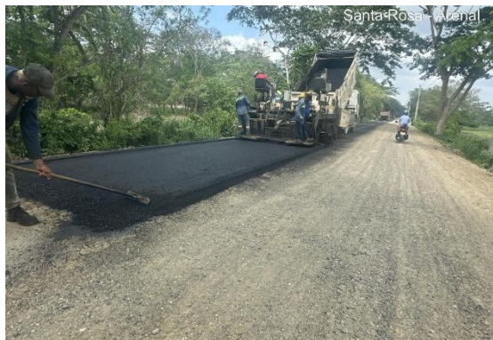
Extensión y compactación de mezcla asfáltica
