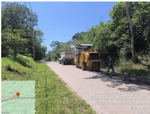
Fresado de pavimento asfáltico
