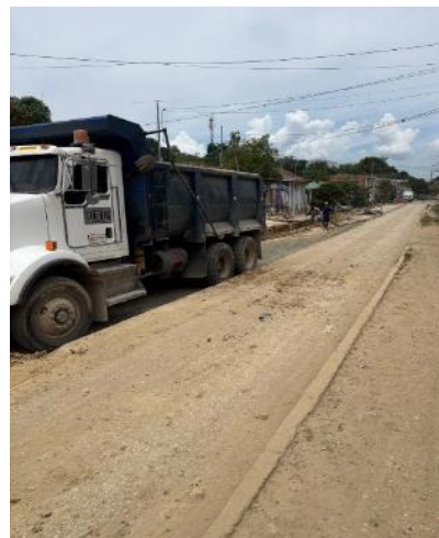
Transporte de materiales provenientes de excavaciones
