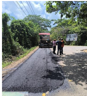
Extensión y compactación de mezcla asfáltica
