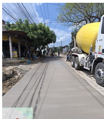
Suministro y colocación de Pavimento Rígido en Villanueva
