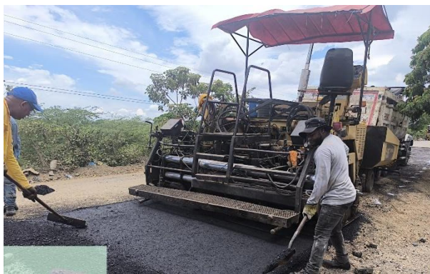
Extensión y compactación de mezcla asfáltica
