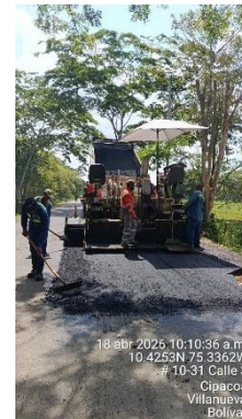
Extensión y compactación de mezcla asfáltica
