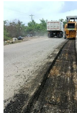
Fresado de pavimento asfáltico
