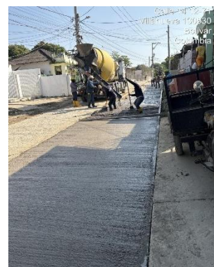
Suministro y colocación de Pavimento Rígido en Villanueva
