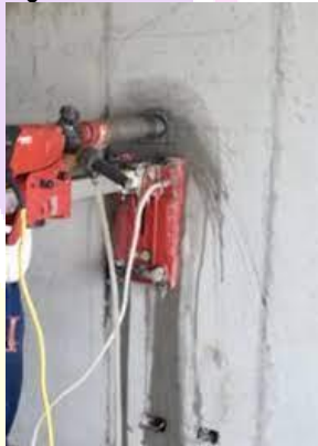
Figura 4.4 Taladro de extracción de núcleos
