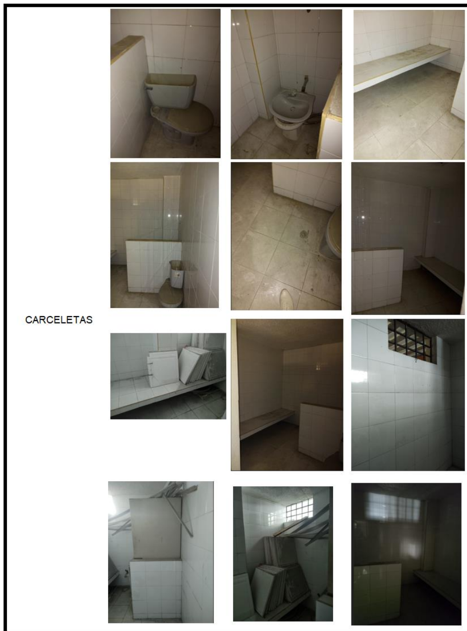
Figura 2.13-7: Fotografías estado actual zona carceletas
