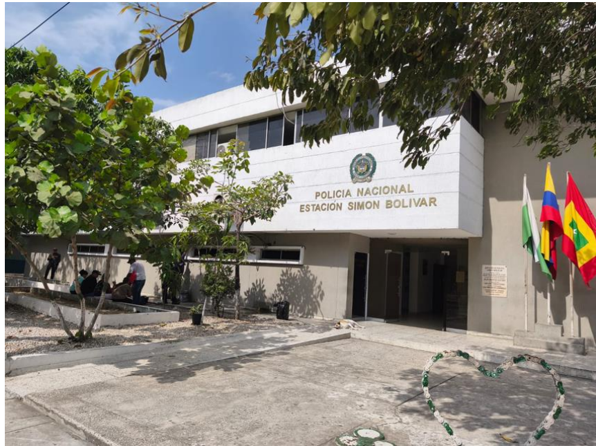
Figura 2.7-1: Fotografía del acceso a la Estación Simón Bolívar
