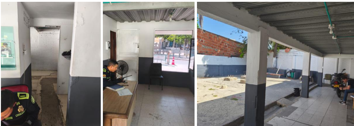
Figura 2.10-2: Fotografías tomadas durante la visita, las cuales se comparten como soporte técnico referencial de las condiciones observadas en sitio y no constituyen documento definitivo ni reemplazan la validación técnica correspondiente
