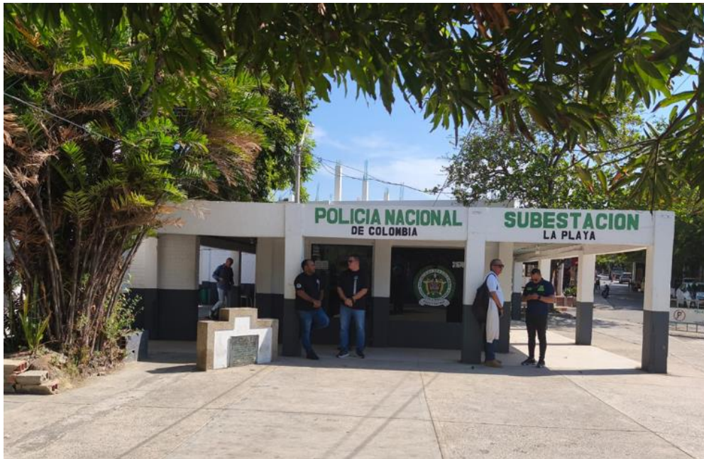
Figura 2.10-1: Fotografía del acceso a la Subestación La Playa
