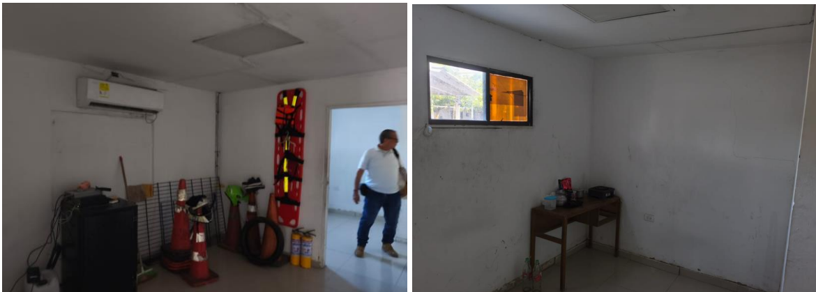
Figura 2.11-2: Fotografías tomadas durante la visita, las cuales se comparten como soporte técnico referencial de las condiciones observadas en sitio y no constituyen documento definitivo ni reemplazan la validación técnica correspondiente
