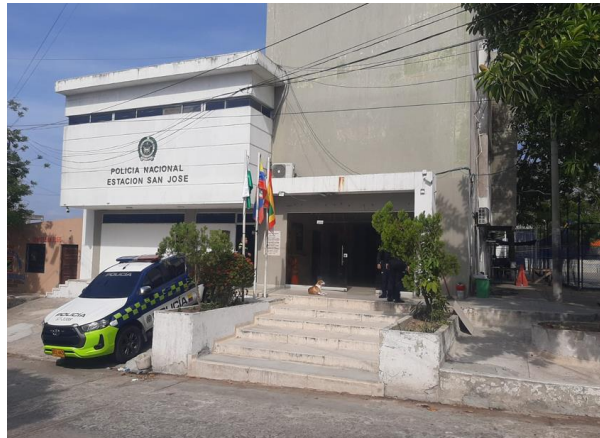
Figura 2.8-1: Fotografía del acceso a la Estación San José.
