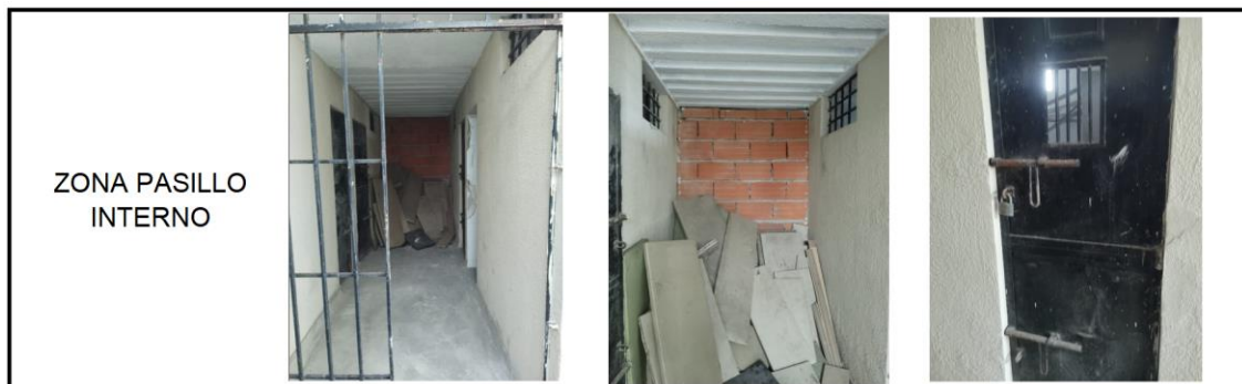
Figura 2.13-5: Fotografías estado actual zona pasillo interno
