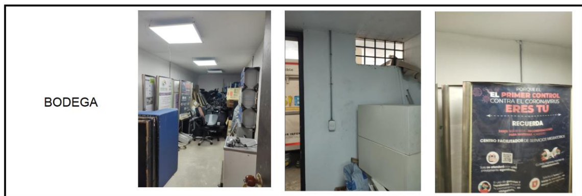
Figura 2.13-6: Fotografías estado actual zona bodega
