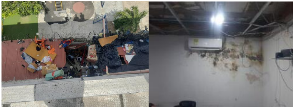
Figura 2.8-2: Fotografías tomadas durante la visita, las cuales se comparten como soporte técnico referencial de las condiciones observadas en sitio y no constituyen documento definitivo ni reemplazan la validación técnica correspondiente.
