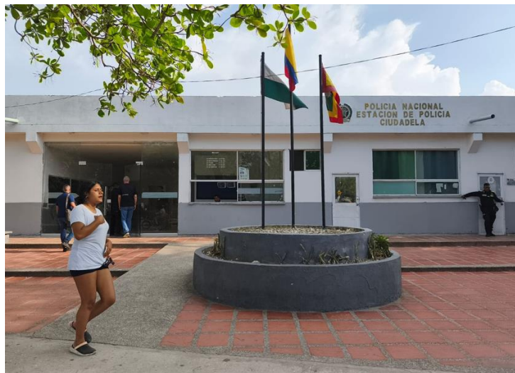
Figura 2.9-1: Fotografía del acceso a la Estación Ciudadela.
