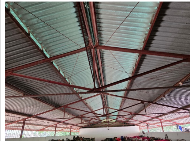
Foto 13: Estado actual del sector a intervenir
