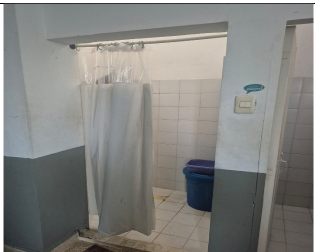
Foto 02: Estado actual del sector a intervenir
