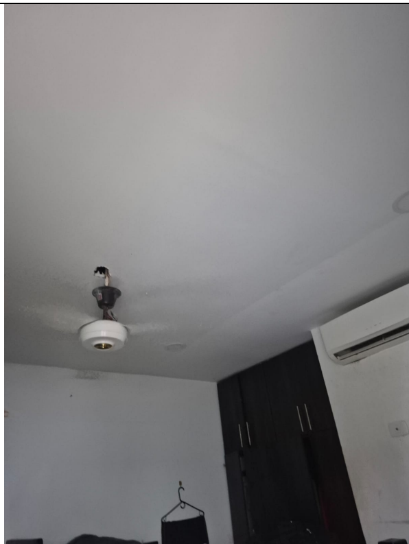
Foto 12: Estado actual del sector a intervenir
