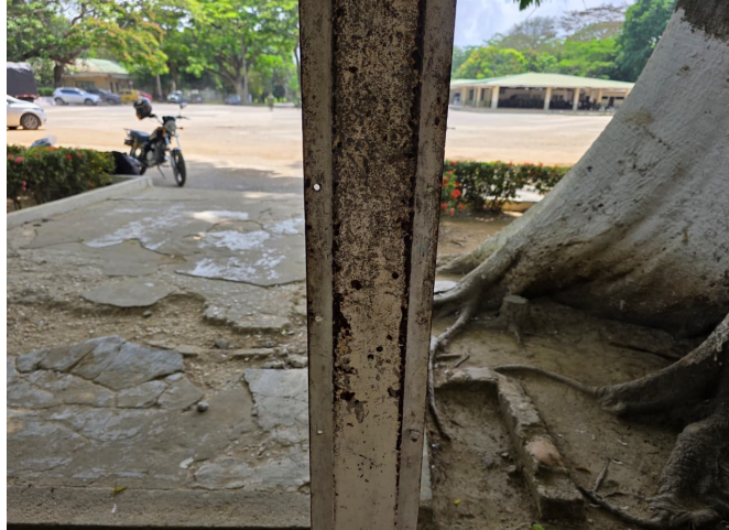
Foto 18: Estado actual del sector a intervenir
