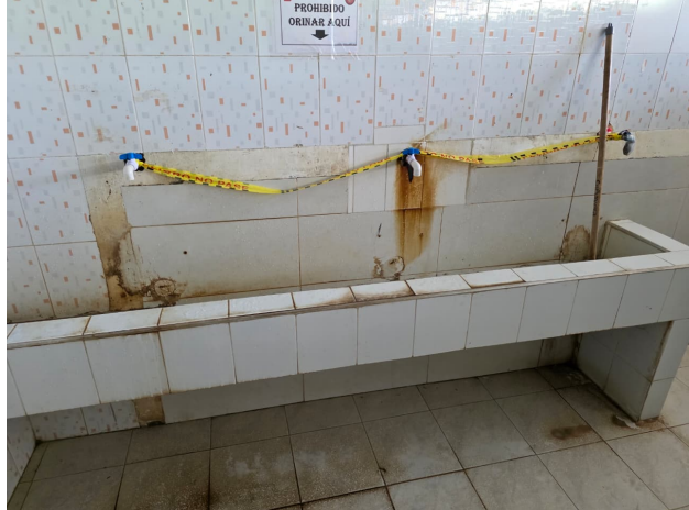
Foto 14: Estado actual del sector a intervenir
