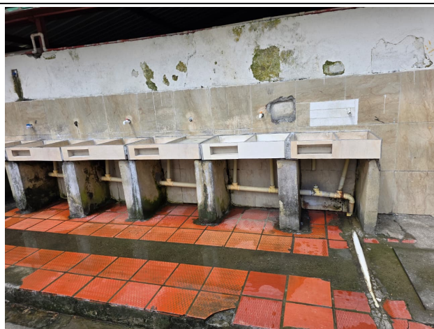
Foto 15: Estado actual del sector a intervenir
