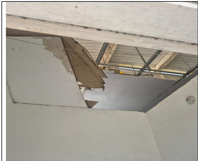
Foto 03: Estado actual del sector a intervenir
