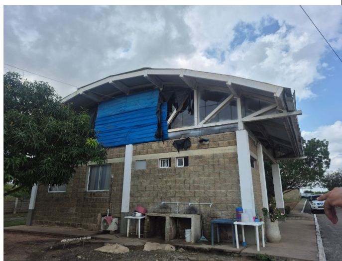
Foto 04: Estado actual del sector a intervenir
