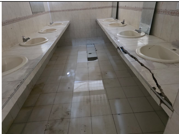
Foto 16: Estado actual del sector a intervenir
