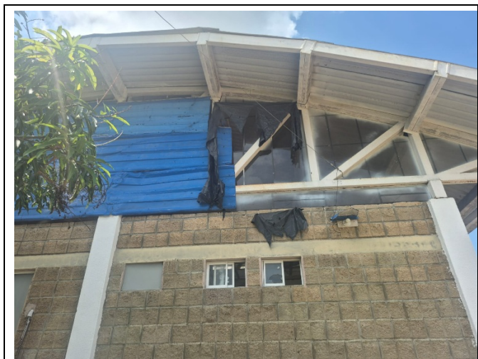
Foto 01: Estado actual del sector a intervenir
