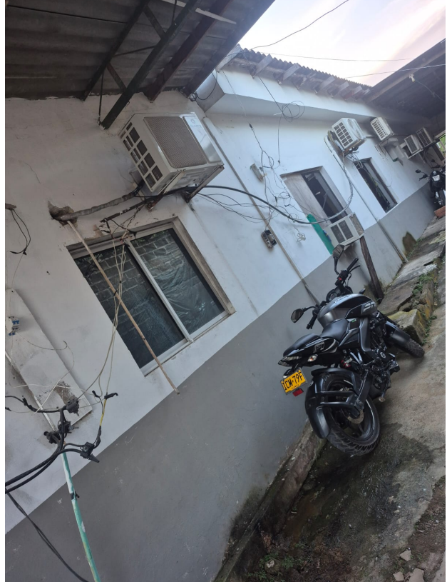
Foto 10: Estado actual del sector a intervenir
