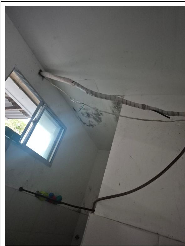
Foto 11: Estado actual del sector a intervenir
