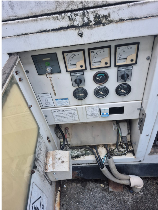
Foto 09: Estado actual del sector a intervenir
