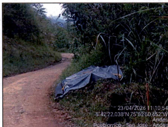
Ilustración 12. Protección con plástico de material sobrante de excavación.
