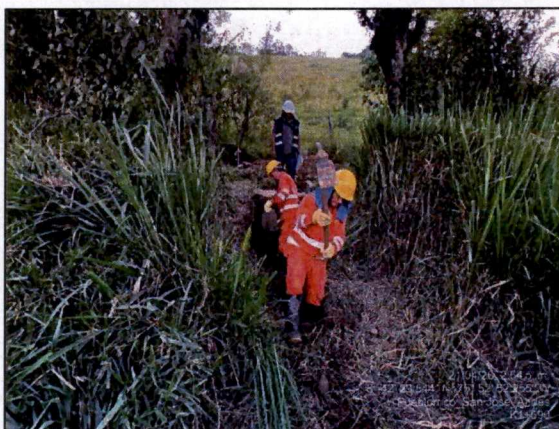
Ilustración 6. Limpieza obras transversales.
