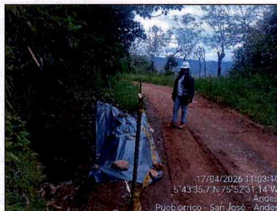
Ilustración 9. Manejo de material sobrante de excavación.
