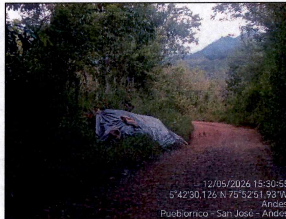
Ilustración 10. Manejo de material sobrante de excavación.
