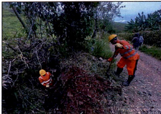
Ilustración 5. Limpieza obras transversales.
