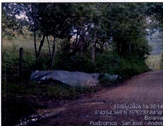
Ilustración 14. Protección con plástico de material sobrante de excavación.
