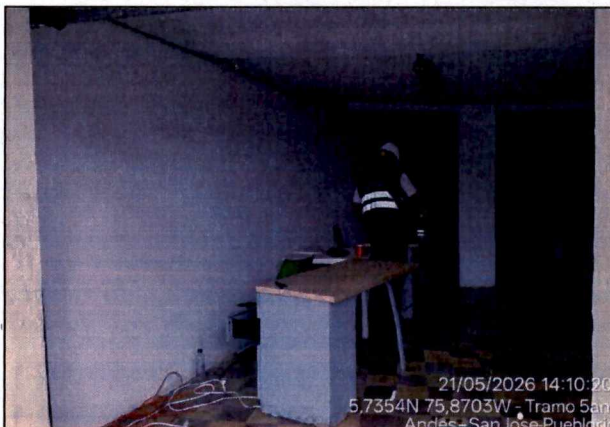
Ilustración 20. Campamento de contratista corregimiento San José.
