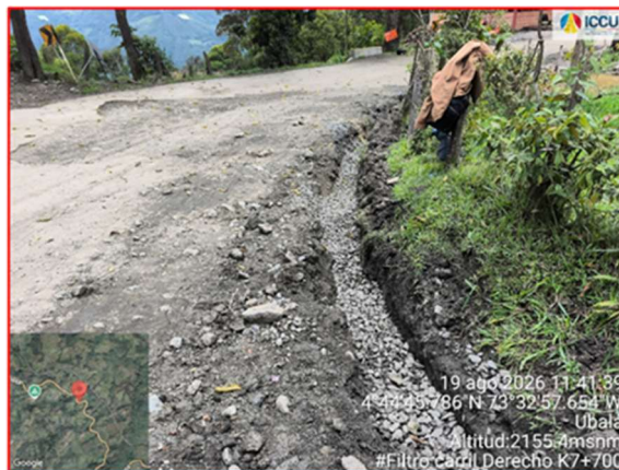
Instalación de Geodren Vial e instalación de tubería 4" perforada Tramo 2
