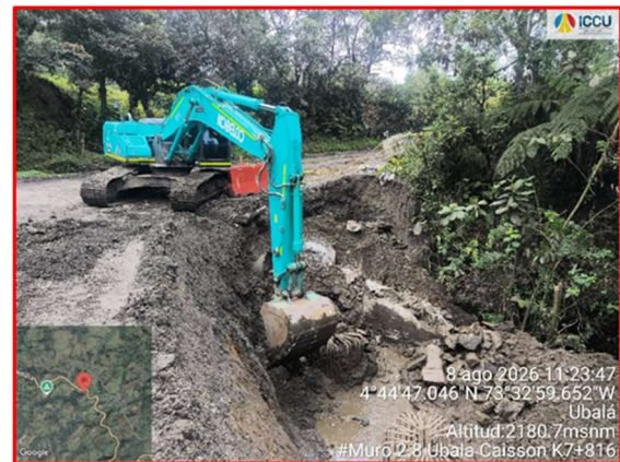
Excavación para construcción modulo de muro en voladizo k7+816
