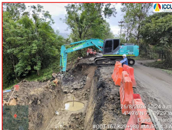
Excavaciones para construcción de muros de cierre en Muro Potreritos k45+120
