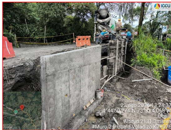
Construcción muro en voladizo 2.8 k7+815
