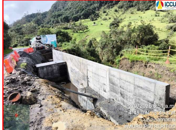
Construcción de muros de cierre Muro Potreritos k45+120
