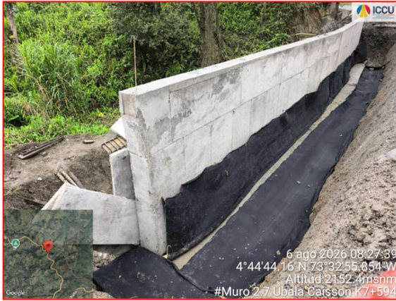
Instalación de Geodren y tubería perforada 4" para el trasdós de los muros
