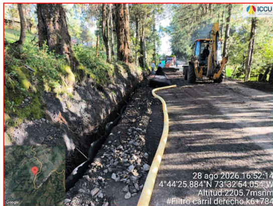
Instalación de Geodren Vial e instalación de tubería 4" perforada Tramo 2
