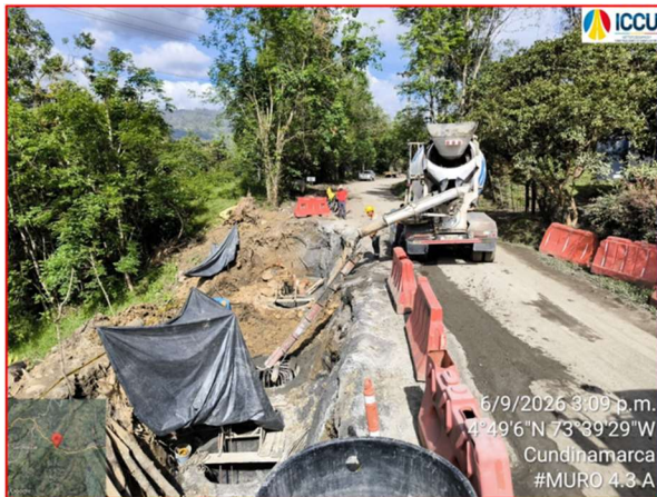
Construcción de caissons Muro 4.3 A k29+039
