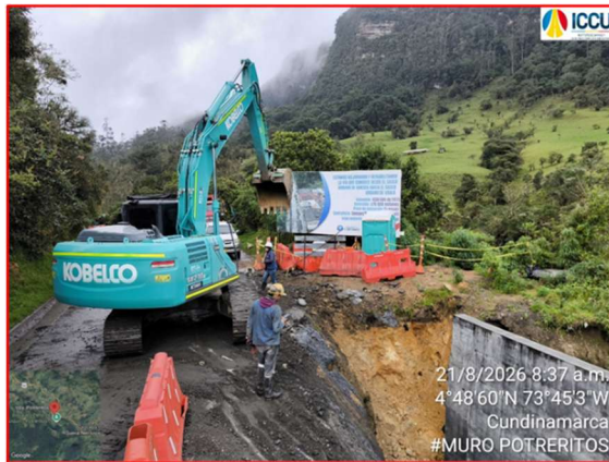
Excavaciones para construcción de muros de cierre en Muro Potreritos k45+120
