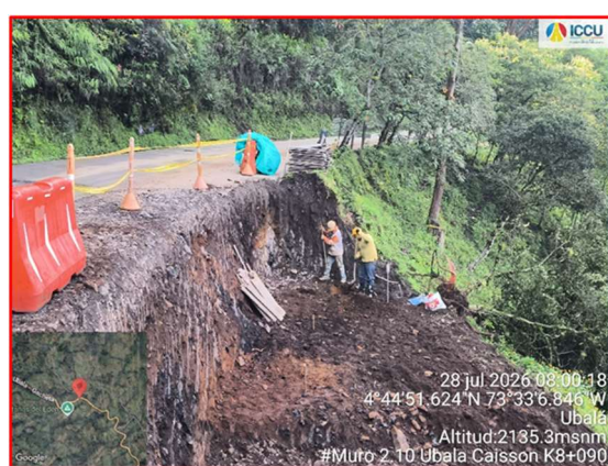
Excavación para construcción del Muro 2.9 k7+976
