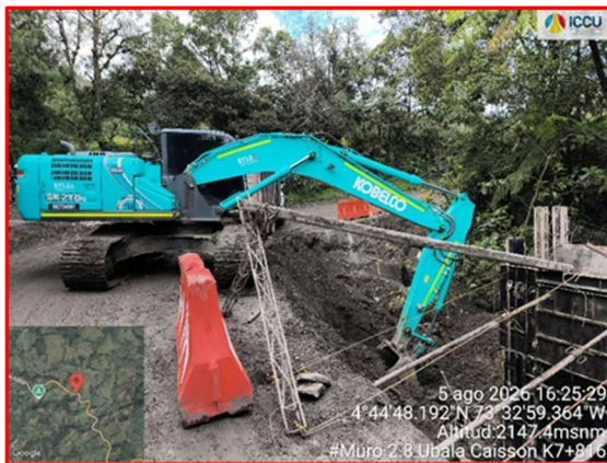
Excavación para construcción modulo de muro en voladizo k7+816
