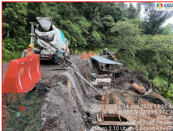
Construcción de muros de cierre Muro Potreritos k45+120
