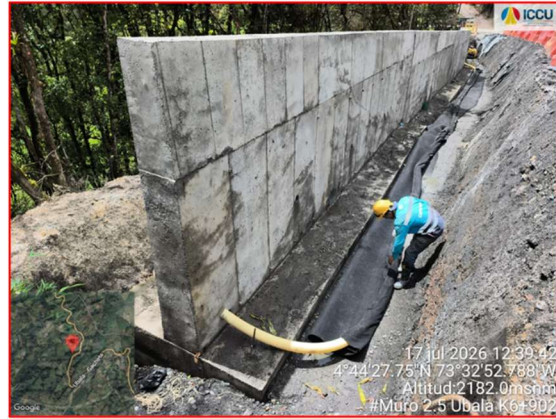
Instalación de Geodren y tubería perforada 4" para el trasdós de los muros
