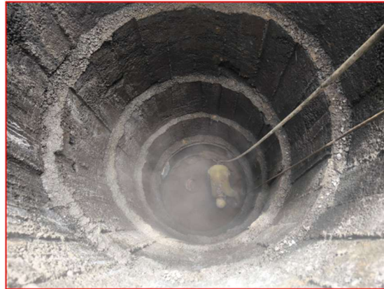
Construcción de caissons Muro 4.3 A k29+039
