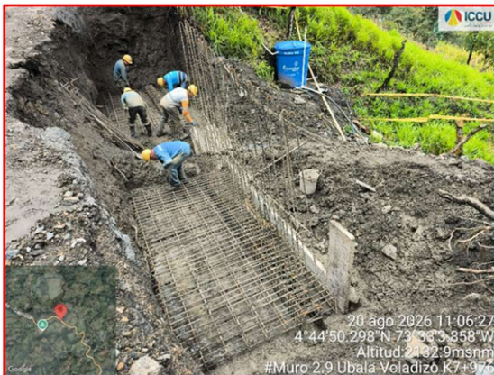
Construcción muro en voladizo 2.8 k7+815
