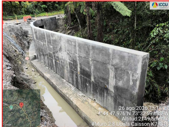
Construcción muro en voladizo 2.8 k7+815
