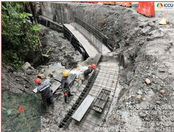
Construcción muro en voladizo 2.8 k7+815
