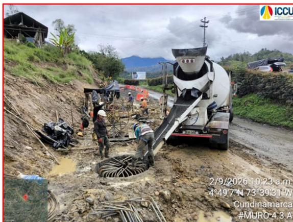
Construcción de caissons Muro 4.3 A k29+039
