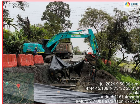
Excavaciones para construcción de muros de cierre lateral Muro 2.7 k7+594
