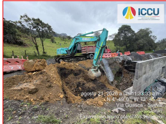
Excavaciones para construcción de muros de cierre en Muro Potreritos k45+120
