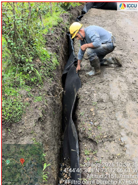
Instalación de Geodren Vial e instalación de tubería 4" perforada Tramo 2
