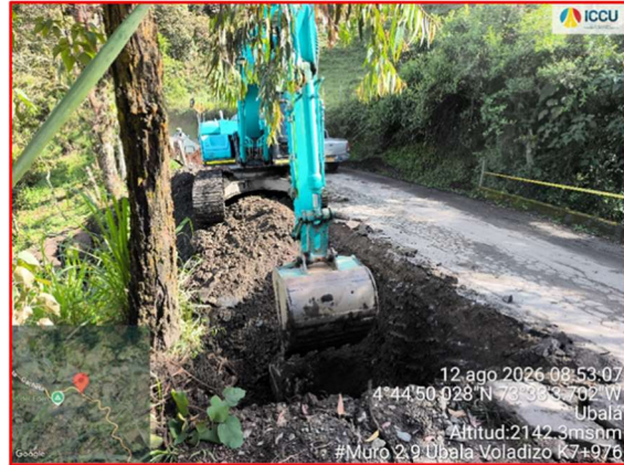
Excavación para construcción del Muro 2.9 k7+976
