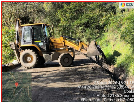
Instalación de Geodren Vial e instalación de tubería 4" perforada Tramo 2
