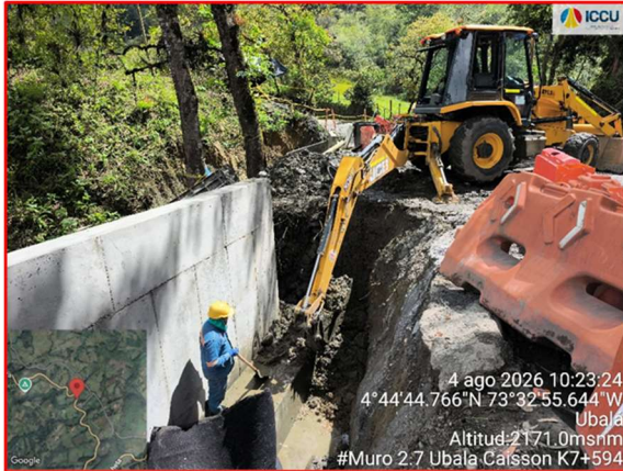
Excavaciones para construcción de muros de cierre lateral Muro 2.7 k7+594
