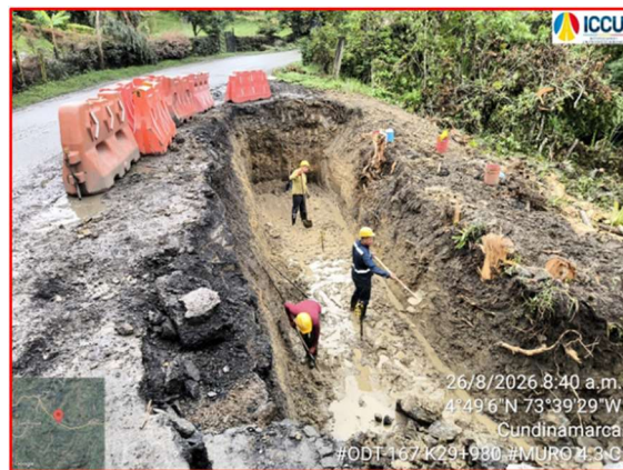
Excavaciones para construcción de muros de cierre en Muro Potreritos k45+120
