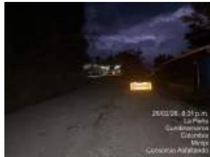
INSTALACIÓN DE SEÑALIZACIÓN NOCTURNA
