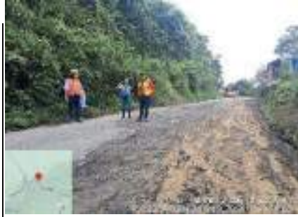
Demolición de carpeta asfáltica 100 ml
