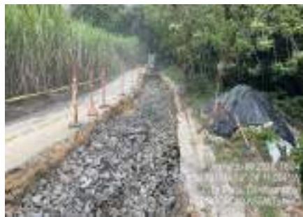
Instalación de rajon 40 ml
