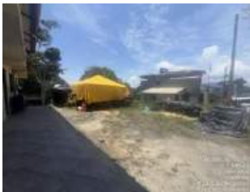
AREA DE ACOPIO DE MATERIALES
