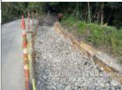
Instalación de rajon 40 ml
