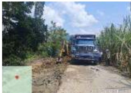
Trasporte de material proveniente de la excavación al acopio
