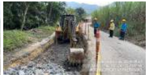
Instalación de rajon 40 ml
