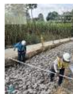
Instalación de rajon 40 ml
