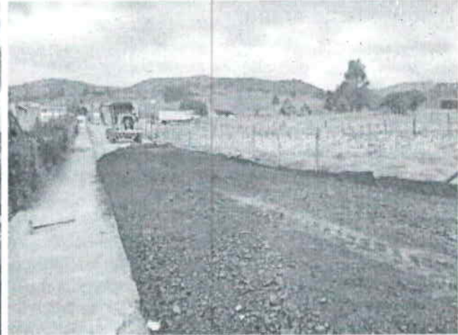
Fig. Mejoramiento de vías urbanas con material de Fresado
