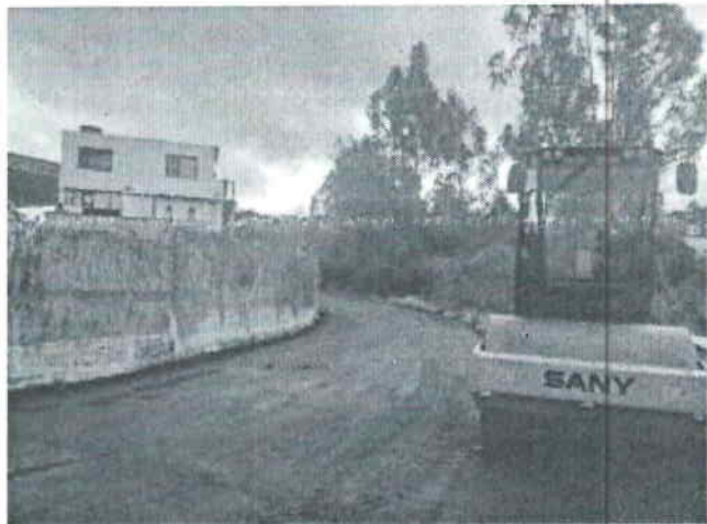
Fig. Mejoramiento de vías urbanas con material de Fresado
