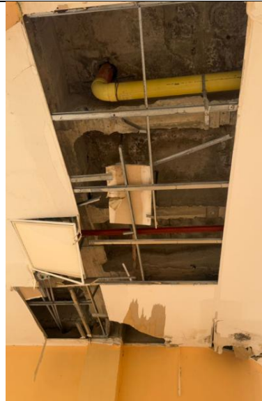
Ilustración 13 Desprendimiento de cielo falso
