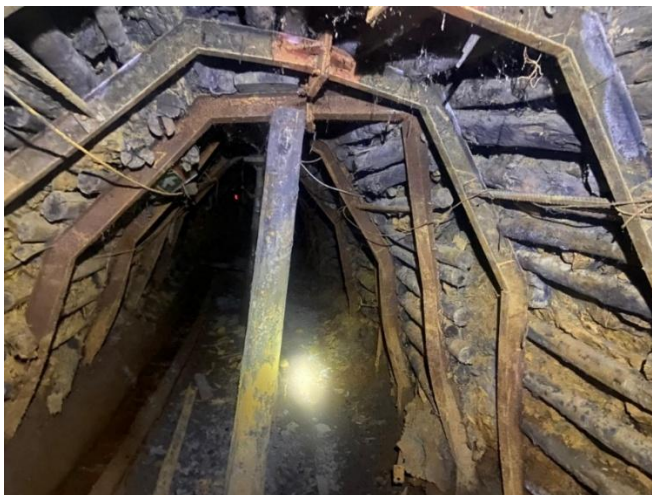
Imagen 2: deformación de la estructura de sostenimiento por presiones del terreno
