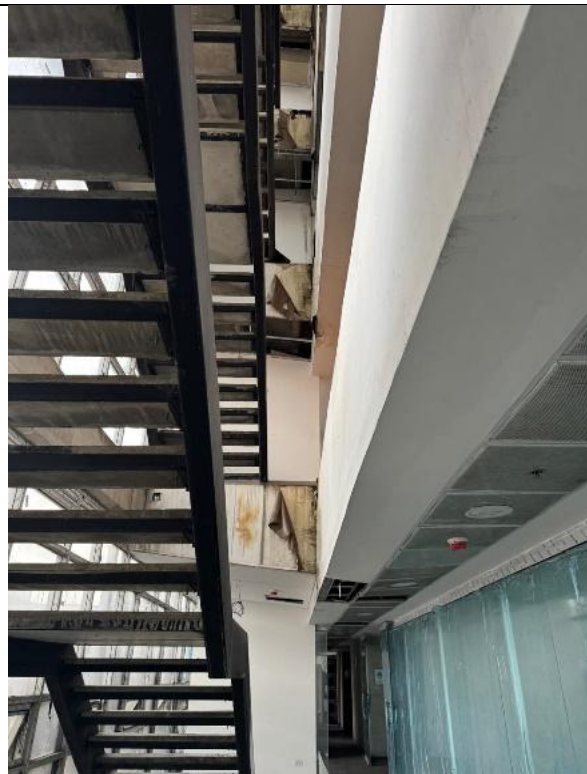
Foto No. 2 – Tipología Escalera metálica Interna de piso 2 a piso 12, sin barandas de protección con alto grado de deterioro por exposición a lluvias.
