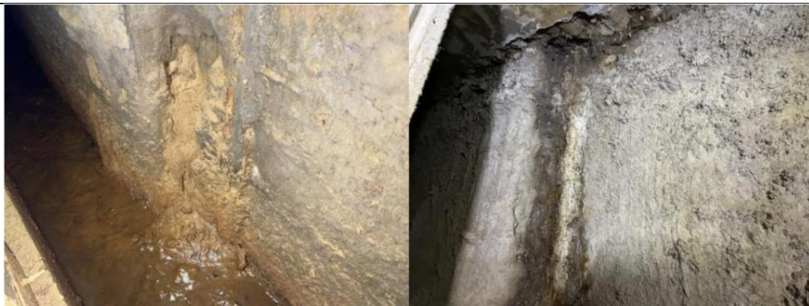
Foto No. 10 - Evidencia fotográfica de filtraciones. Fuente: TIBOCOR
