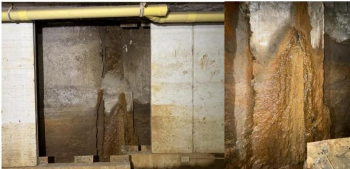
Foto No. 10 - Evidencia fotográfica de filtraciones. Fuente: TIBOCOR
