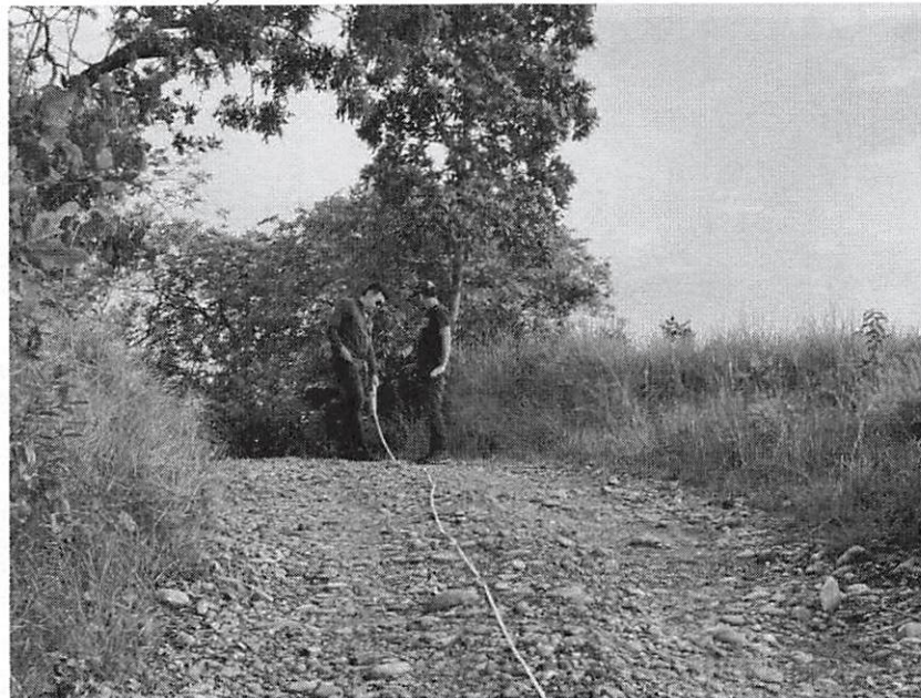
Foto 4: Proyección Placa Huella en Vereda Caño Rico Sector sobandero
