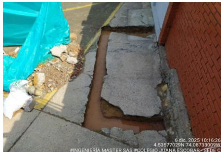
FOTO 3: Demolición placa de contrapiso en concreto zona shut basura. Colegio Juana Escobar - Sede C
