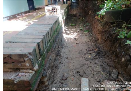
FOTO 1: Demolición de cuneta en concreto en zona talud. Colegio Los Alpes - Sede B
