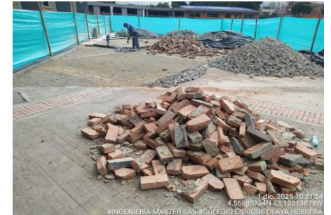
FOTO 2: Demolición cintas en ladrillo zona dura cancha. Colegio Enrique Olaya Herrera - Sede A
