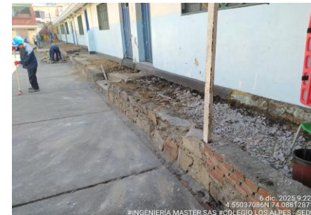
FOTO 2: Demolición de placa de contrapiso en concreto zona cancha. Colegio Los Alpes - Sede B
