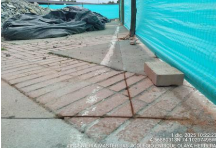
FOTO 1: Corte con pulidora zona dura cancha. Colegio Enrique Olaya Herrera - Sede A
