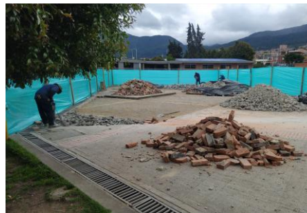
FOTO 5: Protección provisional de cárcamos zona dura cancha. Colegio Enrique Olaya Herrera - Sede A
