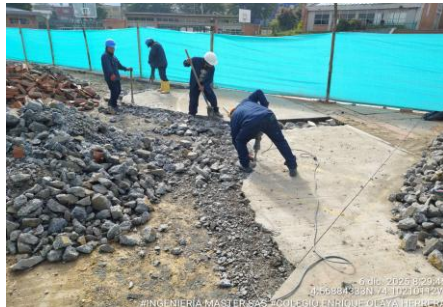
FOTO 3: Demolición placa contrapiso zona dura cancha. Colegio Enrique Olaya Herrera - Sede A
