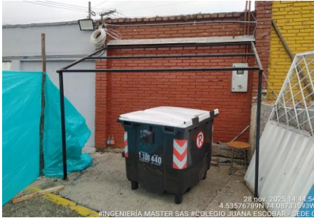
FOTO 1: Desmante estructura de cubierta zona shut basura. Colegio Juana Escobar - Sede C
