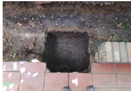
FOTO 3: Excavación manual en terreno natural en zona talud. Colegio Los Alpes - Sede B
