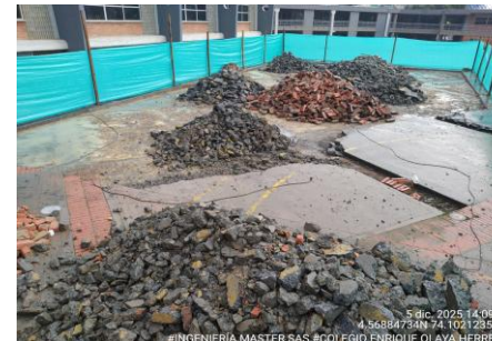
FOTO 4: Trasiego y acopio de RCD zona dura cancha. Colegio Enrique Olaya Herrera - Sede A
