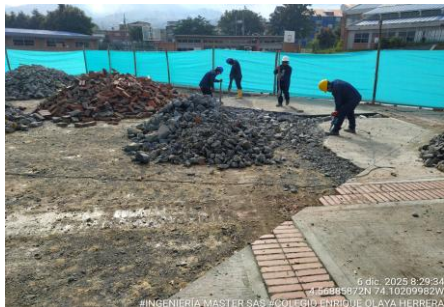
FOTO 3: Demolición placa contrapiso zona dura cancha. Colegio Enrique Olaya Herrera - Sede A
