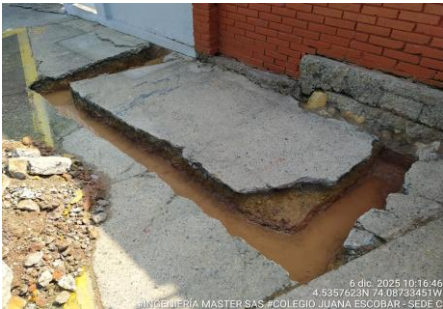
FOTO 3: Demolición placa de contrapiso en concreto zona shut basura. Colegio Juana Escobar - Sede C
