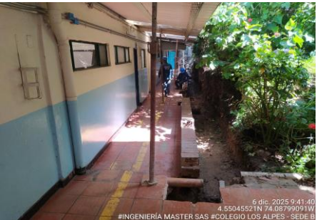
FOTO 3: Excavación manual en terreno natural en zona talud. Colegio Los Alpes - Sede B
