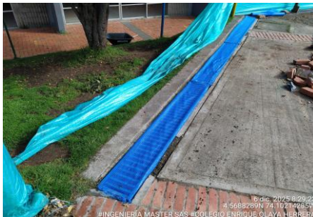
FOTO 5: Protección provisional de cárcamos zona dura cancha. Colegio Enrique Olaya Herrera - Sede A
