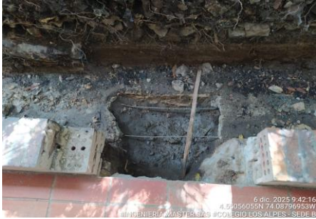
FOTO 1: Demolición de cuneta en concreto en zona talud. Colegio Los Alpes - Sede B
