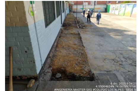
FOTO 2: Demolición de placa de contrapiso en concreto zona cancha. Colegio Los Alpes - Sede B
