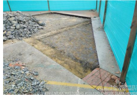
FOTO 1: Corte con pulidora zona dura cancha. Colegio Enrique Olaya Herrera - Sede A
