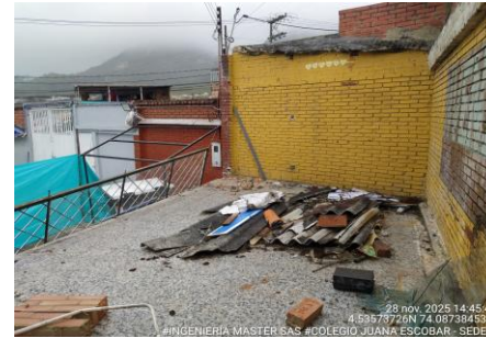
FOTO 2: Orden y aseo zona aula almacén.. Colegio Juana Escobar - Sede C
