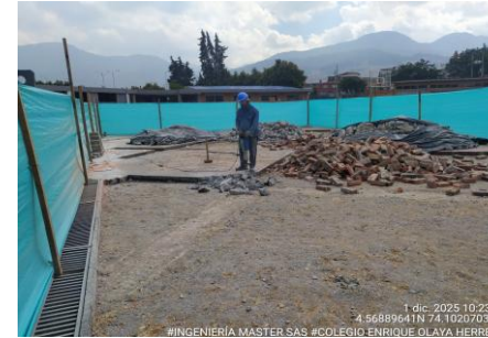
FOTO 2: Demolición cintas en ladrillo zona dura cancha. Colegio Enrique Olaya Herrera - Sede A
