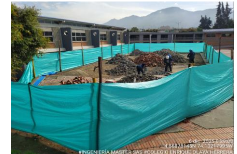
FOTO 4: Trasiego y acopio de RCD zona dura cancha. Colegio Enrique Olaya Herrera - Sede A
