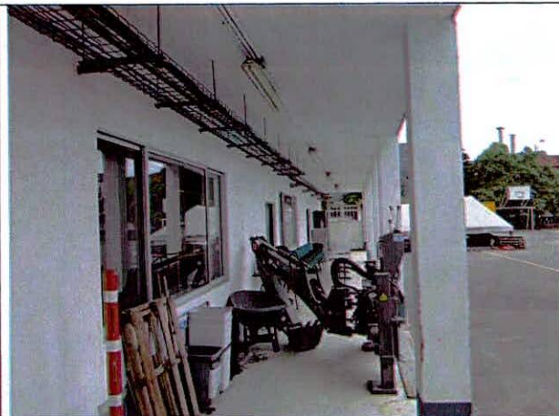
Foto 22. Sector suroriental del primer piso, buen estado.
