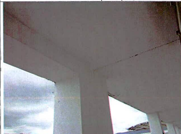
Foto 24. Elementos estructurales y junta en buen estado.
