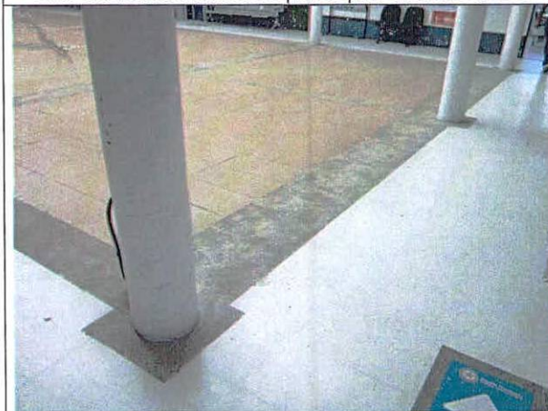
Foto 19. Elementos estructurales, primer piso, buen estado.
