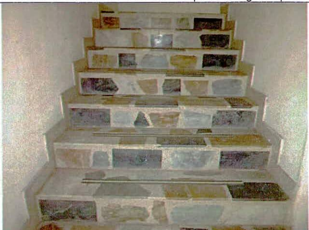
Foto 42. Escaleras a segundo piso, sin daño estructural.
