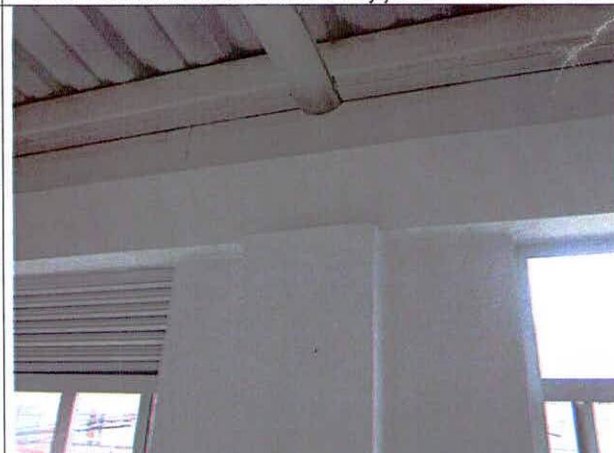
Foto 26. Nudos viga columna en buen estado.
