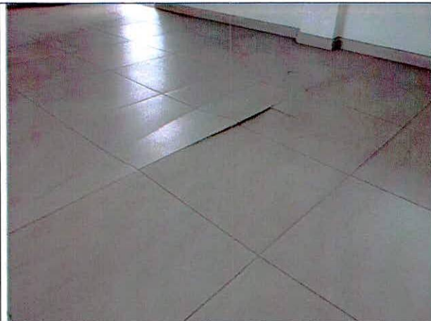
Foto 39. Levantamiento de las baldosas del entrapiso.
