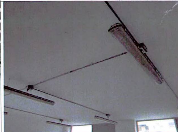
Foto 38. Entrepiso del segundo nivel, buen estado.
