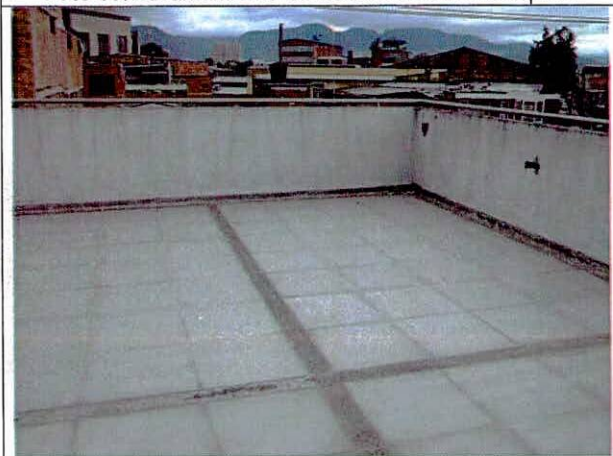
Foto 41. Placa de tercer piso, azotea en buen estado.
