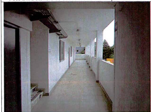
Foto 23. Segundo piso de la edificación de tres niveles.
