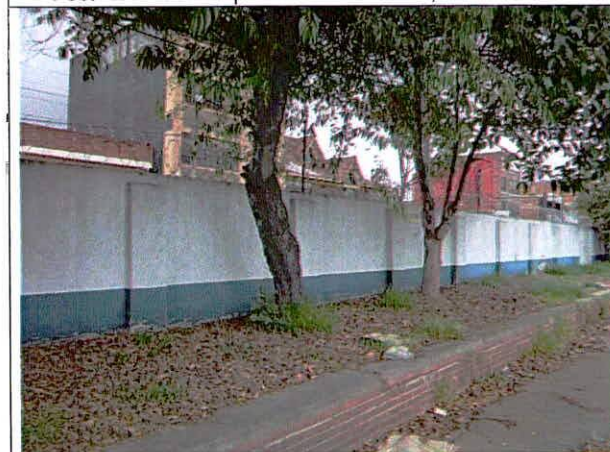
Foto 49. Muro de cerramiento perimetral.
