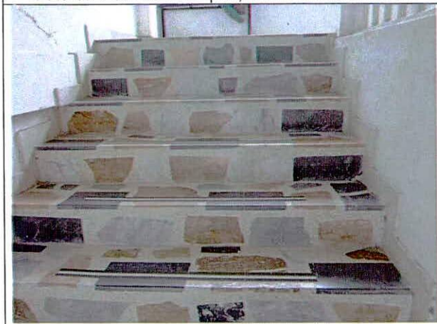
Foto 43. Escaleras a tercer nivel, no se detecta daño.
