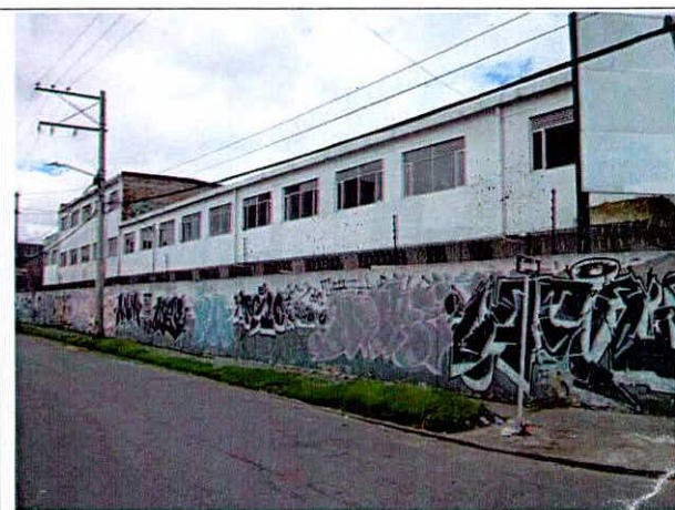
Foto 2. Fachada sobre la Carrera 72 J Bis, buen estado.
