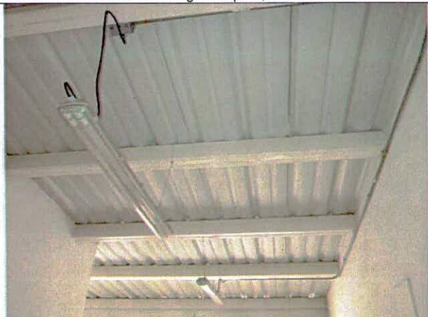
Foto 44. Cubierta sobre segundo piso en buen estado.
