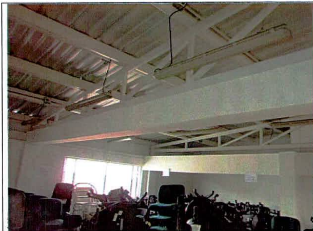
Foto 45. Estructura de cubierta en buenas condiciones.
