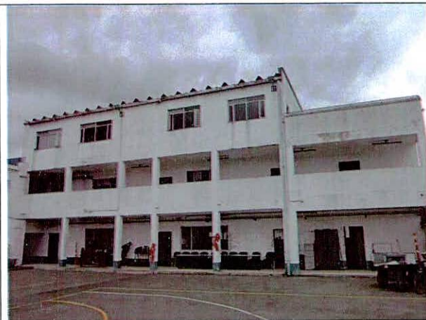
Foto 9. Fachada interna de la edificación de tres pisos.
