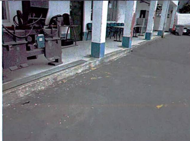
Foto 48. No se detectan deformaciones del piso.
