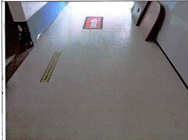
Foto 47. Placa de piso sin daño visible, leve deterioro.
