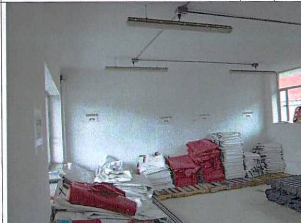
Foto 20. Muros internos de salones del primer piso.
