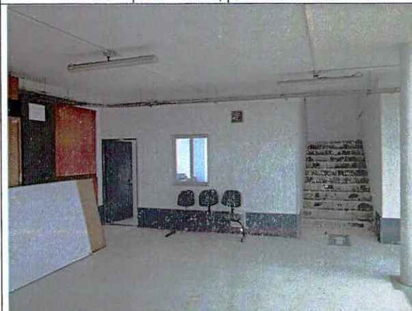
Foto 17. Muros internos del primer piso en buen estado.
