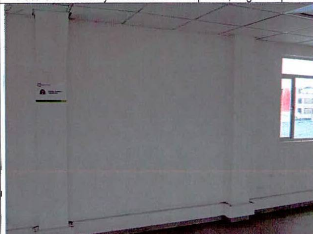
Foto 36. Elementos estructurales tercer piso, sin daño visible.
