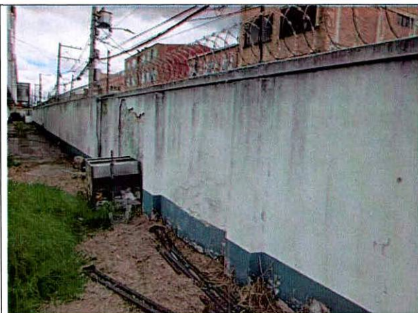
Foto 51. Muro de cerramiento costado oriental.
