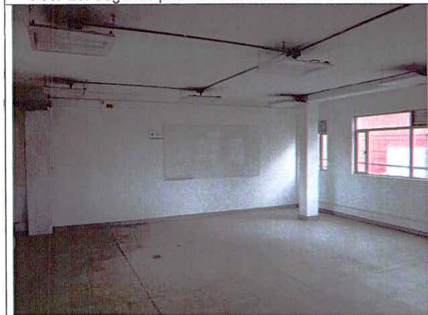
Foto 25. Salones del segundo piso, buen estado.
