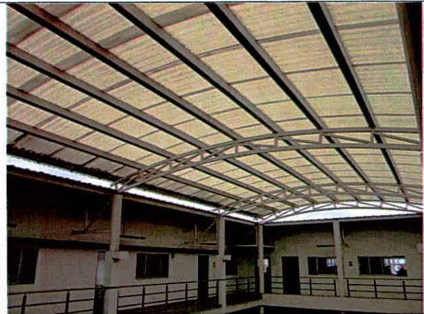
Foto 46. Cubierta sobre patio central sin evidencia de daño.
