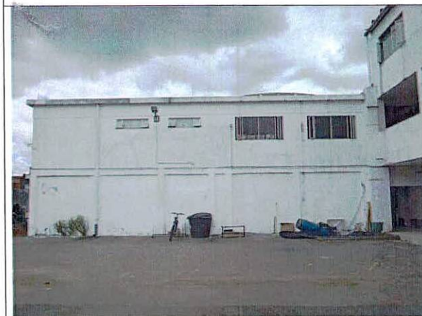
Foto 7. Elementos de concreto en fachada, buen estado.
