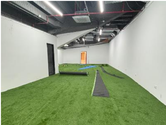
Ilustración 18. Instalación grama sintética zona de calentamiento
