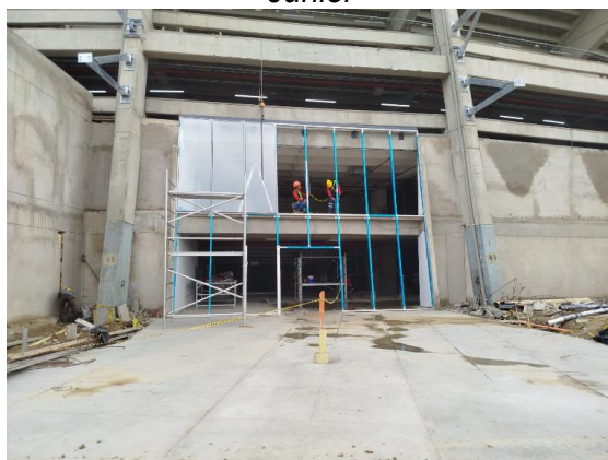
Ilustración 9. Instalación de paneles de aluminio museo Sel. colombia
