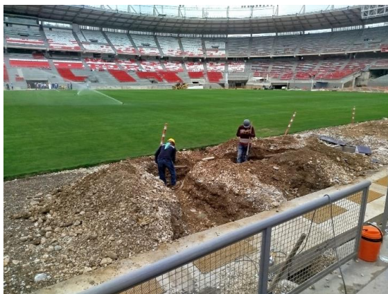
Ilustración 12. Excavaciones perimetrales
