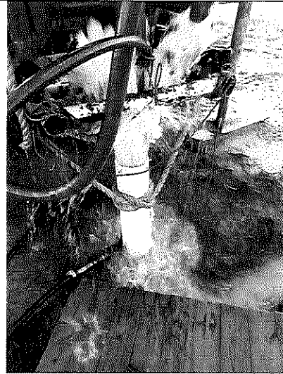
Prueba de bombeo
