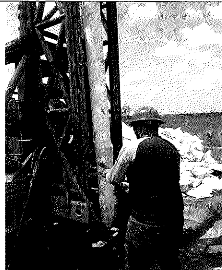
Instalación filtro tubería
