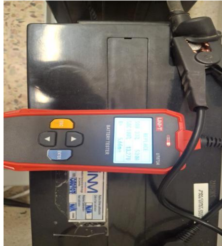
Medición del estado actual de baterías
