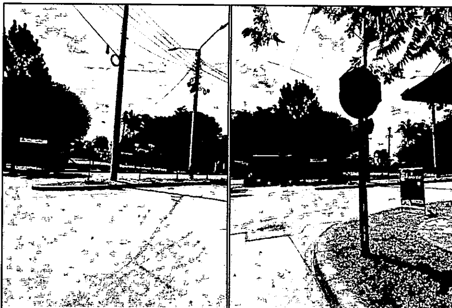
Estado de la demarcación vial en la carrera 12 entre calle 28 y calle 25
