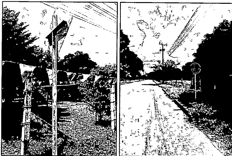
Señales verticales instalada con materiales que no cumplen la normatividad vigente y sin cumplir con la retrorreflectividad adecuada
