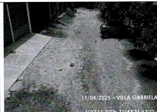
Ilustración 15. Falta de andén peatonal Tramo 4
