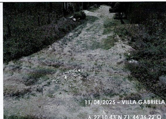
Ilustración 13. Erosión superficial Tramo 4
