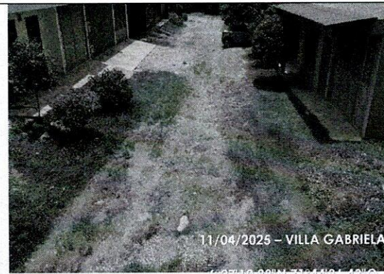
Ilustración 14. Ausencia de iluminación Tramo 4
