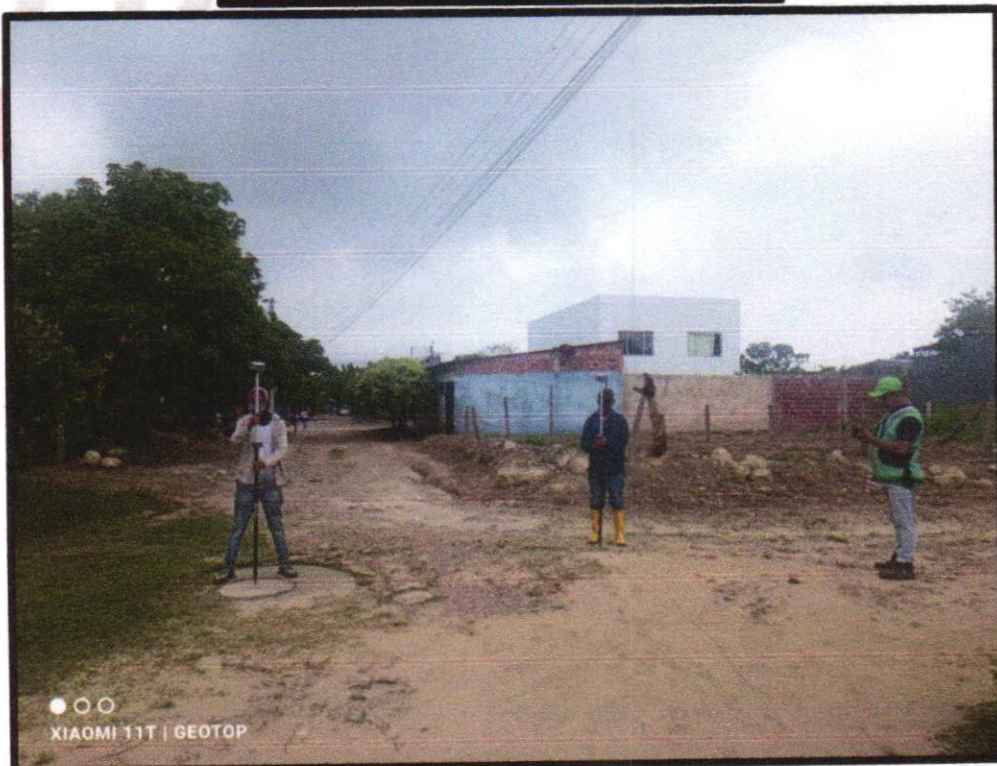
TOMA DE DETALLES EJE DE POZOS DE ALCANTARILLADO
