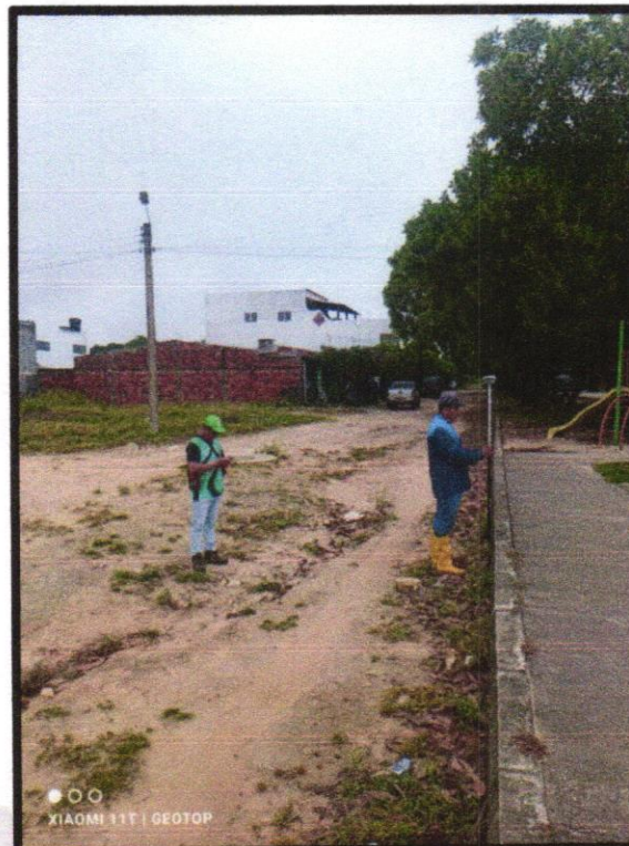
TOMA DE PUNTOS POR SECCIONES TRANSVERSALES
