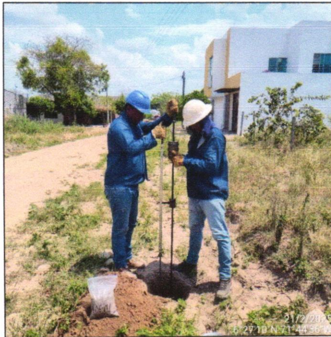
Foto 17. Ensayo de Penetración Dinámica de Cono (PDC) Apique A-06
