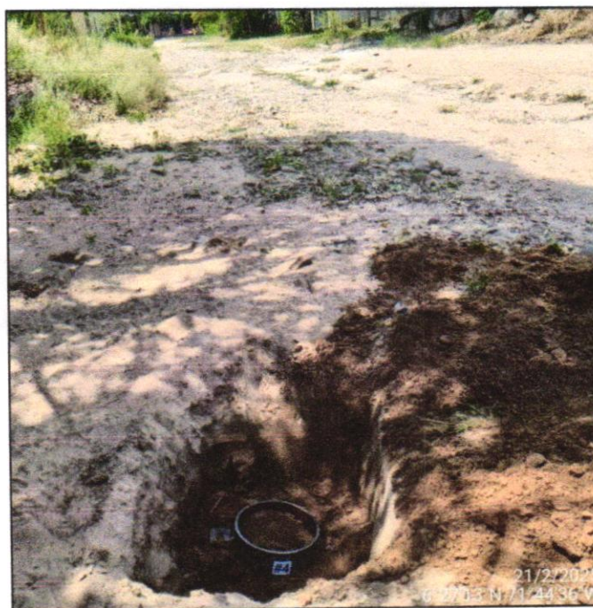
Foto 12. Toma de muestra inalterada en molde CBR Apique A-04
