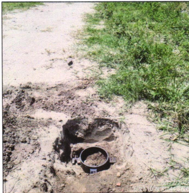
Foto 21. Toma de muestra inalterada en molde CBR Apique A-07
