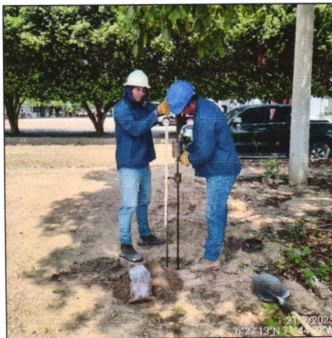
Foto 2. Ensayo de Penetración Dinámica de Cono (PDC) apique A-01
