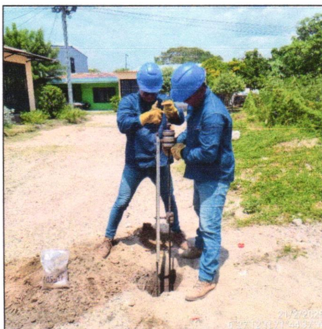
Foto 14. Ensayo de Penetración Dinámica de Cono (PDC) Apique A-05
