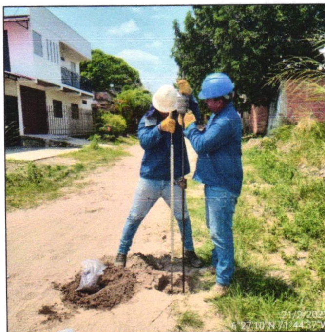
Foto 20. Ensayo de Penetración Dinámica de Cono (PDC) Apique A-07
