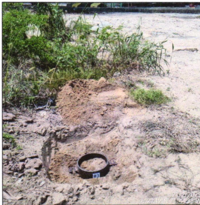
Foto 9. Toma de muestra inalterada en molde CBR Apique A-03
