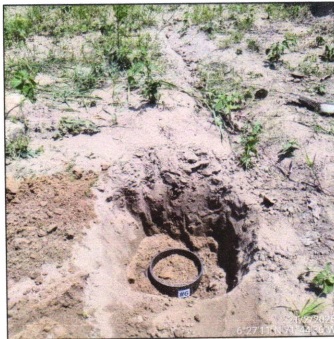
Foto 18. Toma de muestra inalterada en molde CBR Apique A-06
