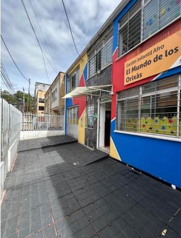
Instalación de pérgola, área del antejardín
