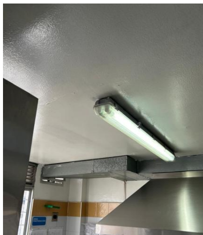
Cambio de luminarias interiores
