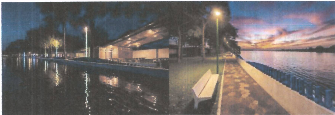
Muro de contención.
