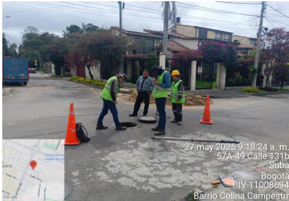
Ilustración 2. Inspección de ubicación de redes de acueducto – Contrato de obra 1010 de 2024
