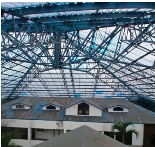
Registro fotográfico afectaciones en cubierta y desgaste pintura de la estructura metálica
