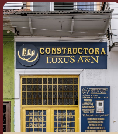
Aviso sobredimensionado junto a exceso de publicidad sobre la fachada.
