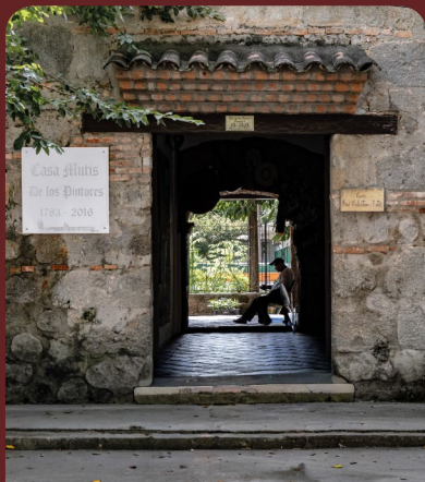
Avisos en piedra y/o vidrios sobre la fachada con dilataores.
