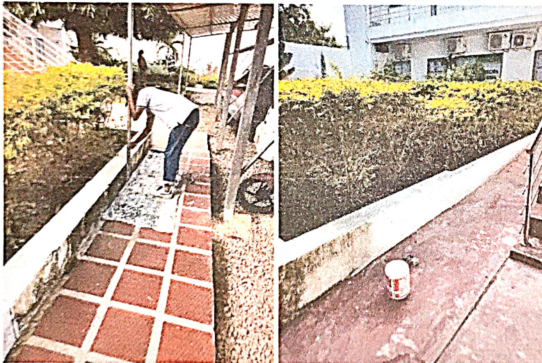
Aplicación de pintura en bordillos y andenes internos.
