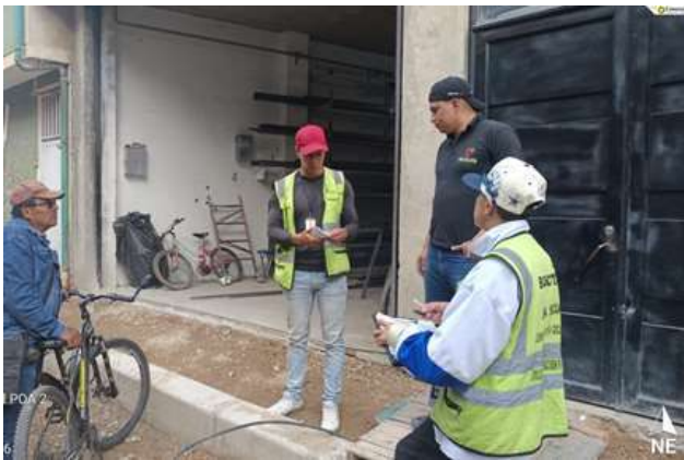
FOTOGRAFIA 07 Socializaciones avance de obra
