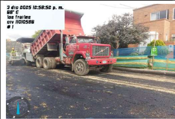
FOTOGRAFIA 07 Instalación de asfalto 11010578
