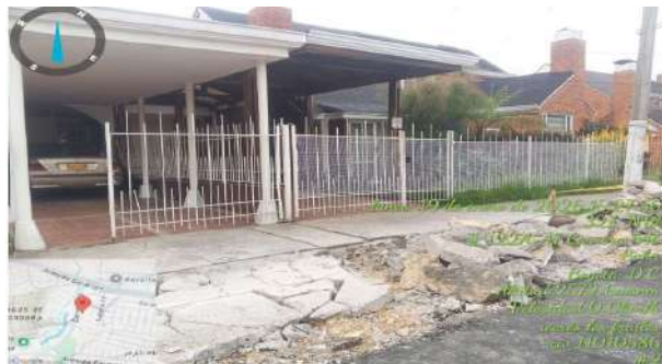
FOTOGRAFIA 2 Demición de rampas 11010586
