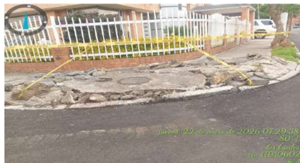
FOTOGRAFIA 06 Demolición de rampas 11010578
