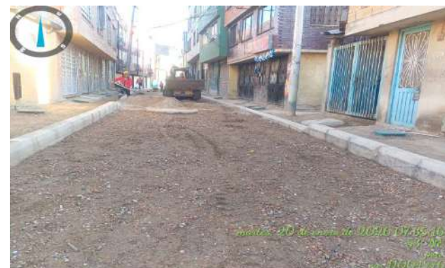
FOTOGRAFIA 3 Instalación de BG-A 11004672
