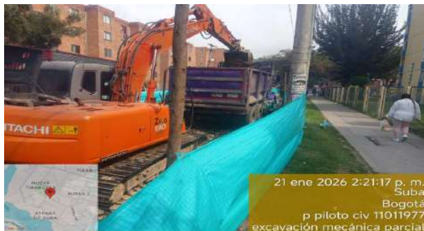
FOTOGRAFIA 05 Cargue de material 11011977
