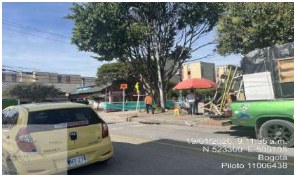
FOTOGRAFIA 1 Instalación de pmt piloto etapa 2
