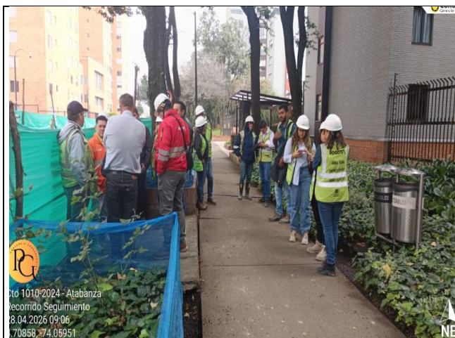
Ilustración 7. Recorrido de obra
