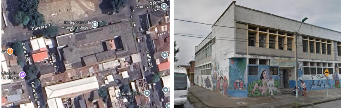
Figura 3. Localización I.E. República de Argentina – Sede Policarpa Salavarrieta.
