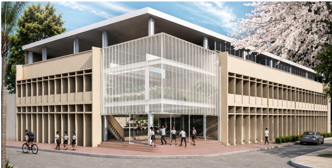
Figura 25. Fachada Calle 23 Institución República de Argentina Sede Policarpa.
