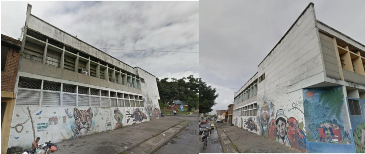
Figura 13-14. Estado actual — Fachada Este, Calle 23
