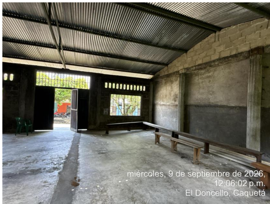
Figura 2. Estado actual del salón comunal- Fuente Propia Secretaria de Planeación y de las Tic's
