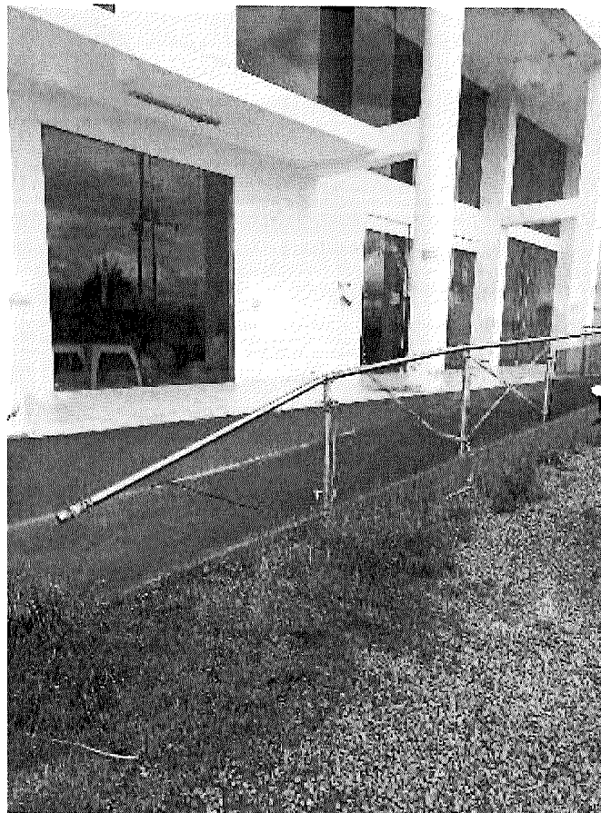
Ilustración 5 ARREGLO DE ESTRUCTURAS DE ACERO INOX (INCLUYE SOLDADURA, INSTALACION DE CHAZOS EXPANSIVOS)- JARDIN COMUNITARIO- VILLAS DEL ROSARIO- ROBLE CENTRO
