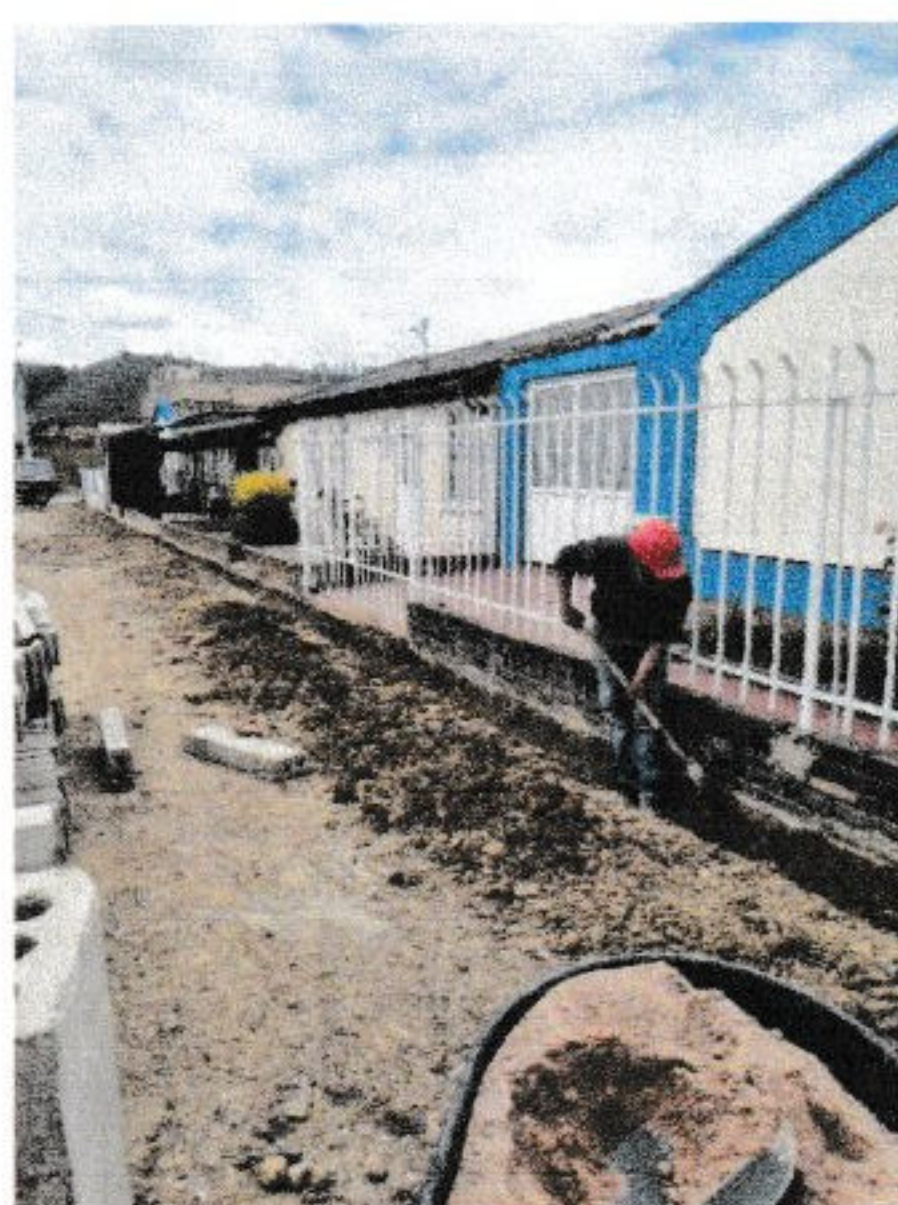
Imagen 9: Evidencia Fotográfica excavación manual – Fuente: Residente de Obra
