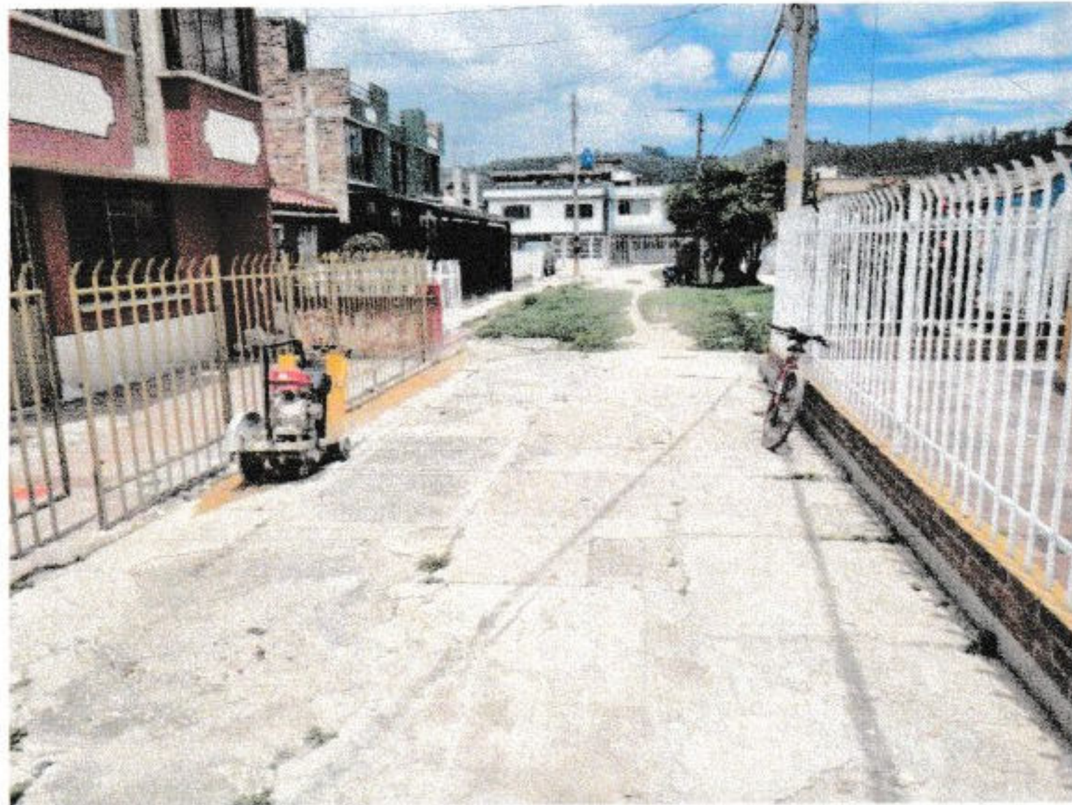
Imagen 26: Evidencia Fotográfica corte pavimento – Fuente: Residente de Obra
