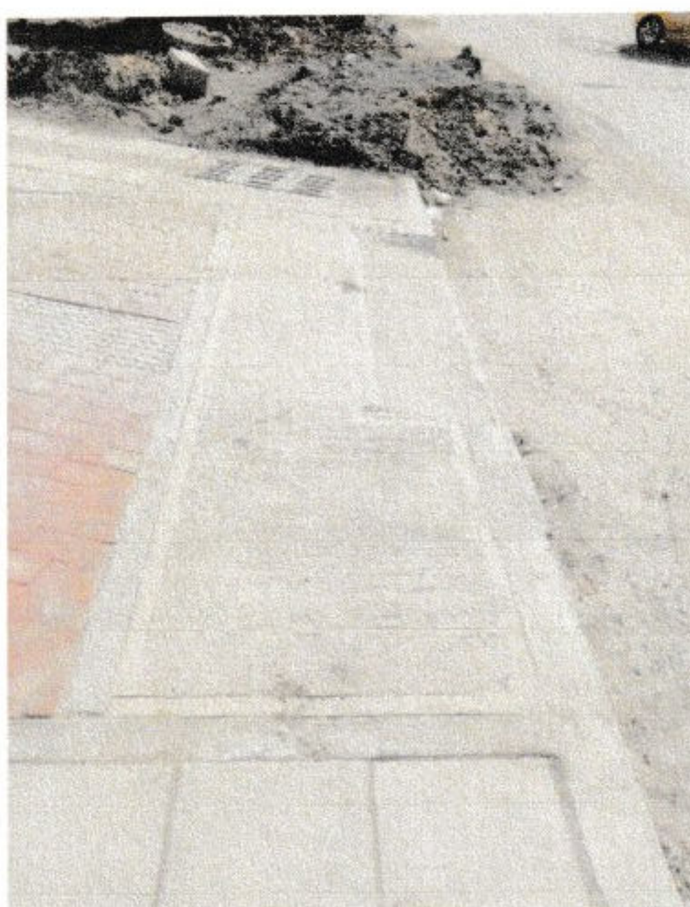
Imagen 16: concreto rampas – Fuente: Residente de Obra
