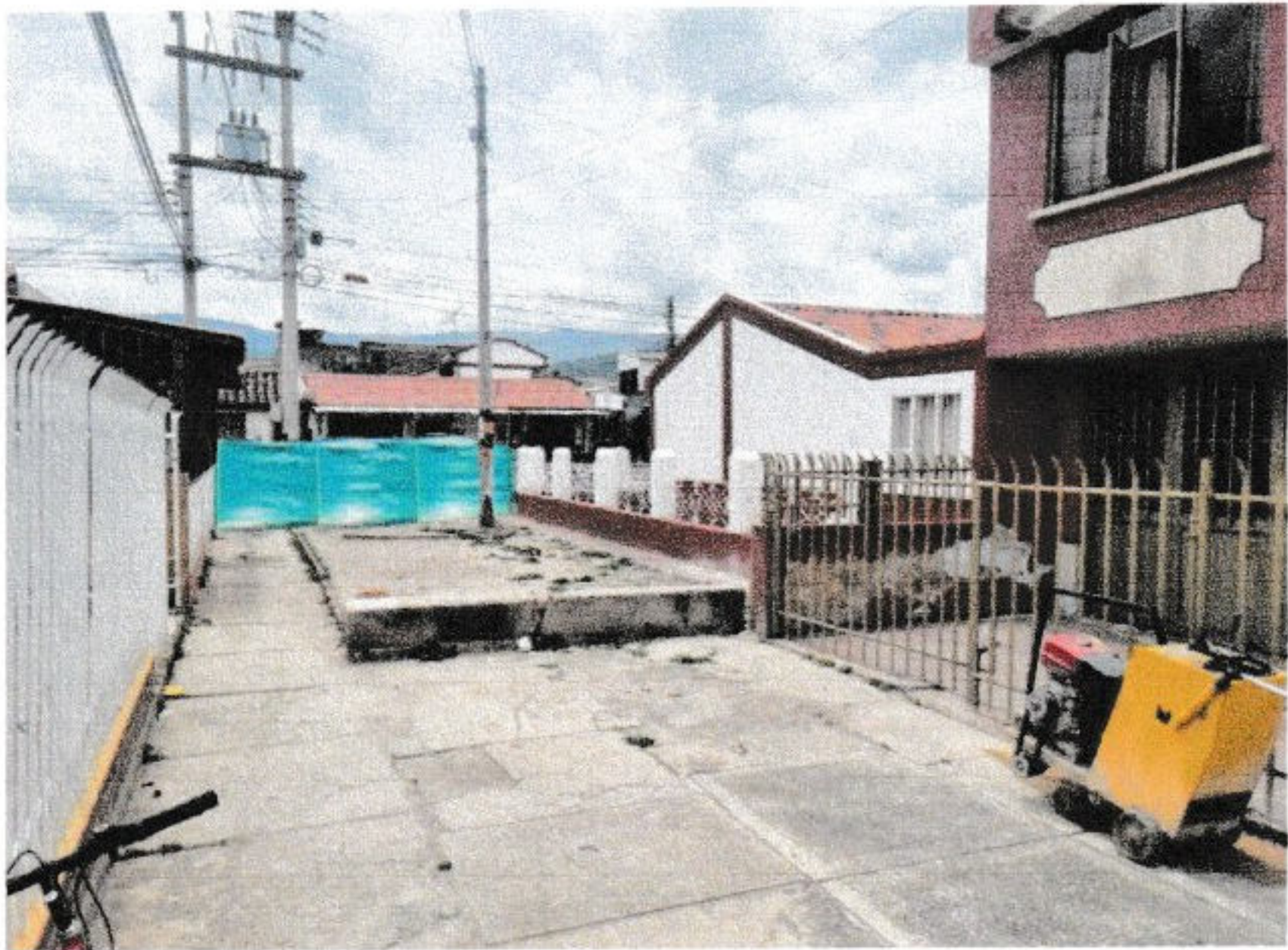
Imagen 5: Evidencia Fotográfica cerramiento vara y lona Fuente: Residente de Obra
