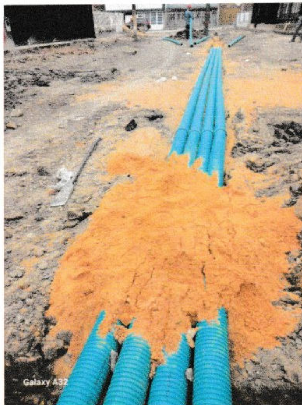
Imagen 20: Evidencia Fotográfica relleno en arena – Fuente: Residente de Obra
