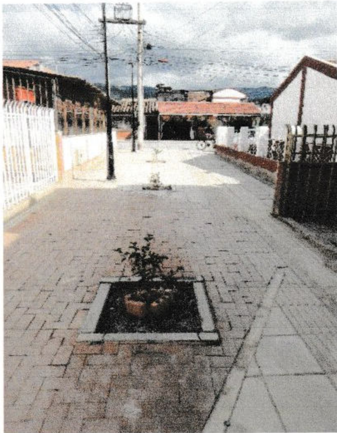
Imagen 29: Evidencia Fotográfica plantación arboles – Fuente: Residente de Obra
