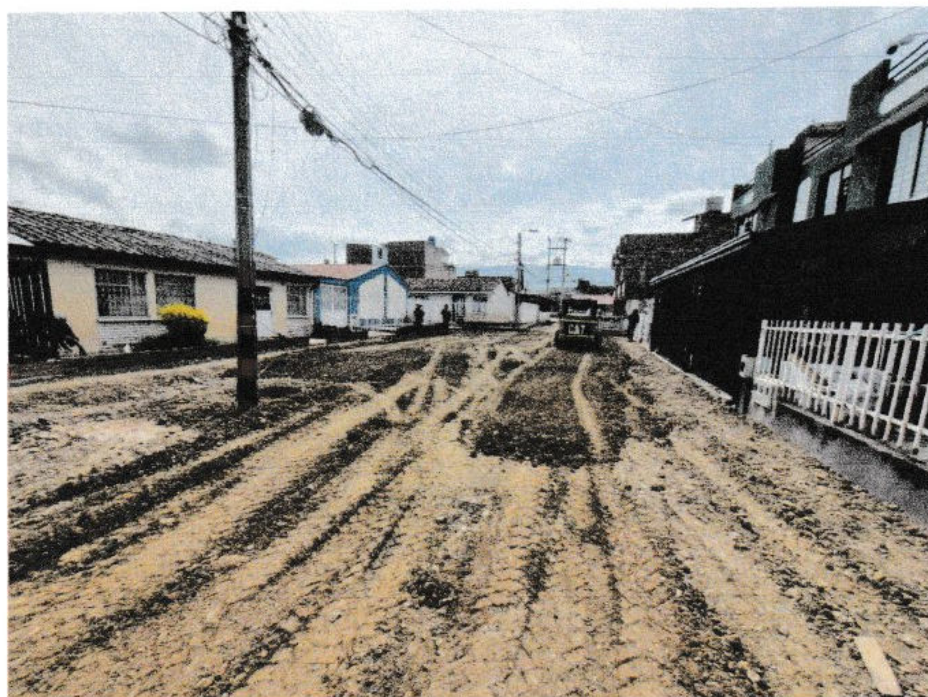
Imagen 11: Evidencia Fotográfica Instalación subbase – Fuente: Residente de Obra
