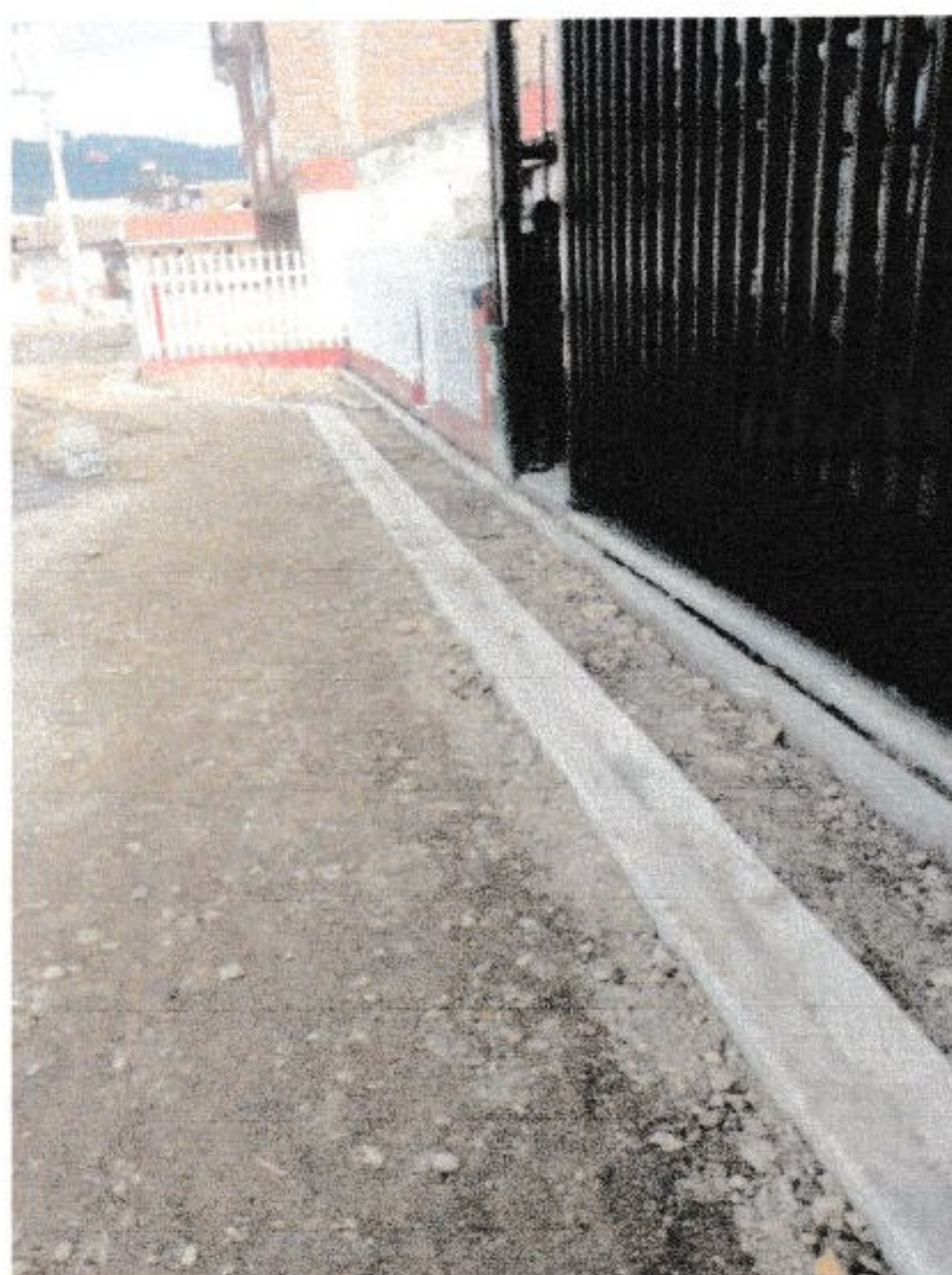
Imagen 18: Evidencia Fotográfica cañuela prefabricada – Fuente: Residente de Obra
