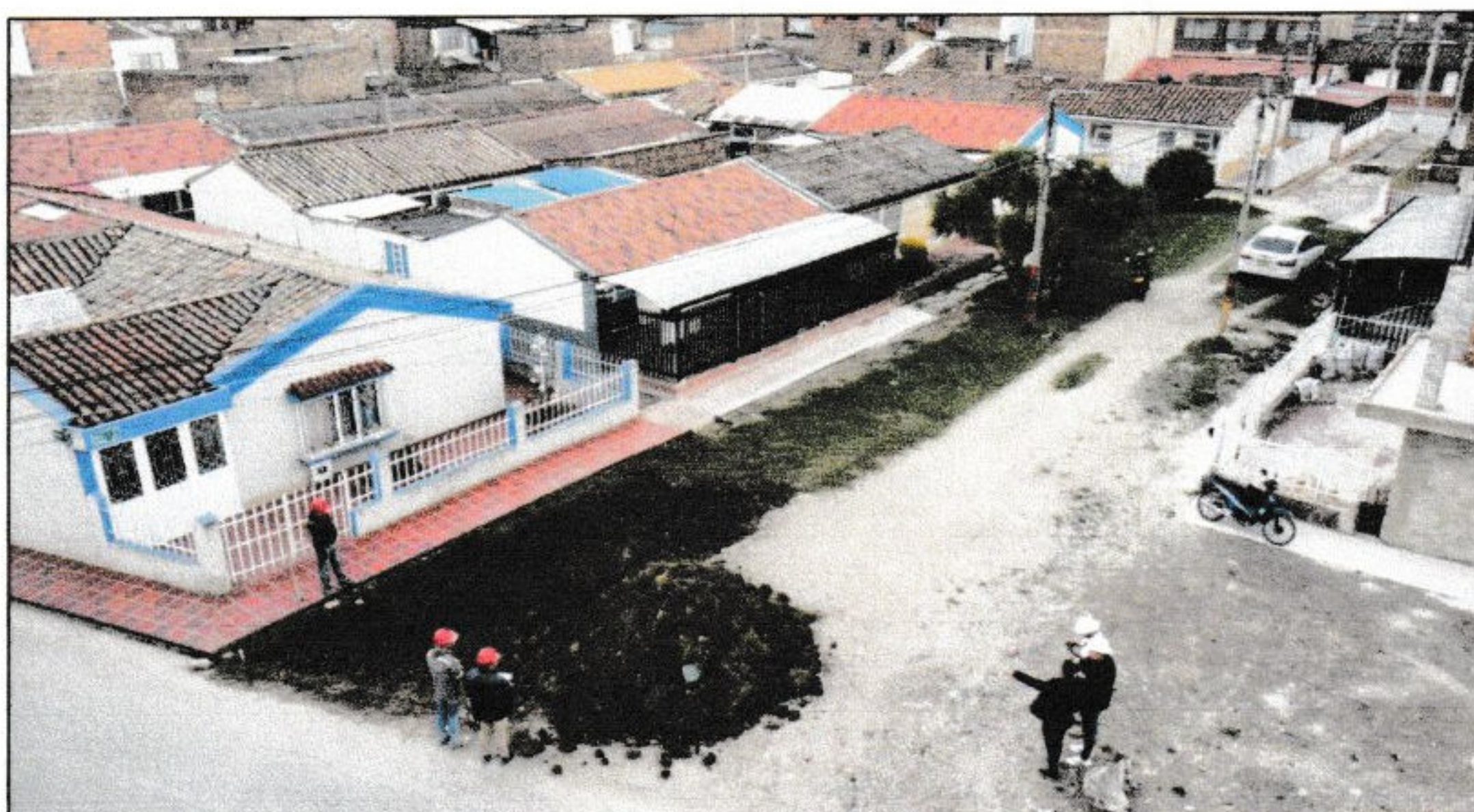
Imagen 2: Localización del proyecto, BARRIO MAGDALENA - Fuente: director de Obra
