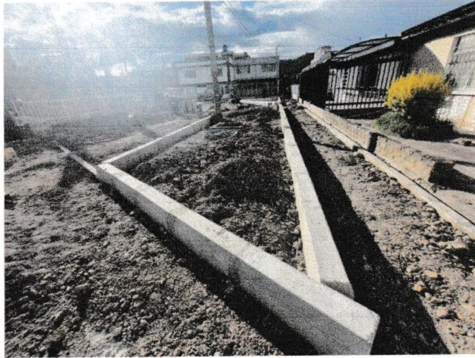
Imagen 12: Evidencia Fotográfica Instalación sardinel A 10 – Fuente: Residente de Obra
