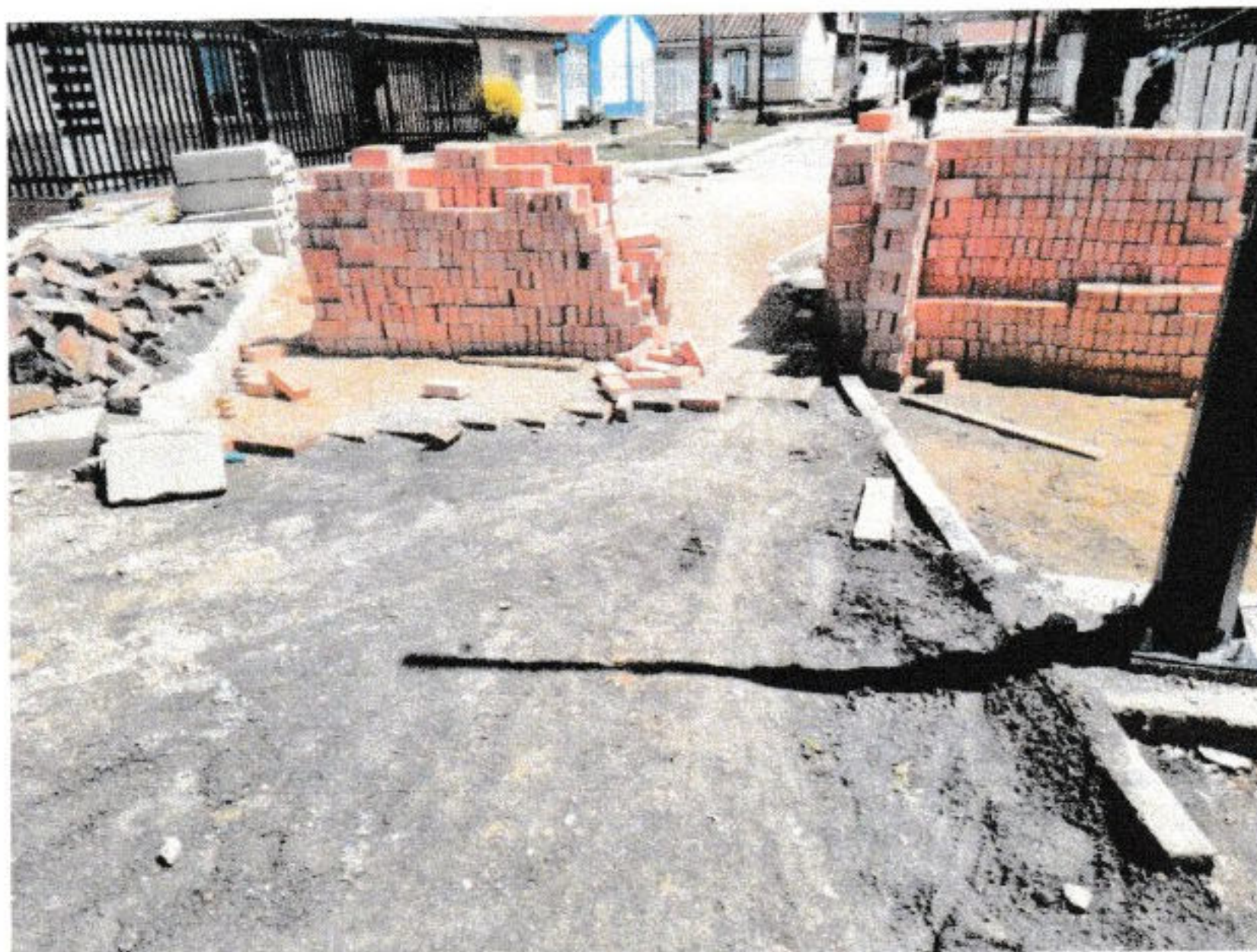
Imagen 15: Evidencia Fotográfica Instalación adoquin – Fuente: Residente de Obra
