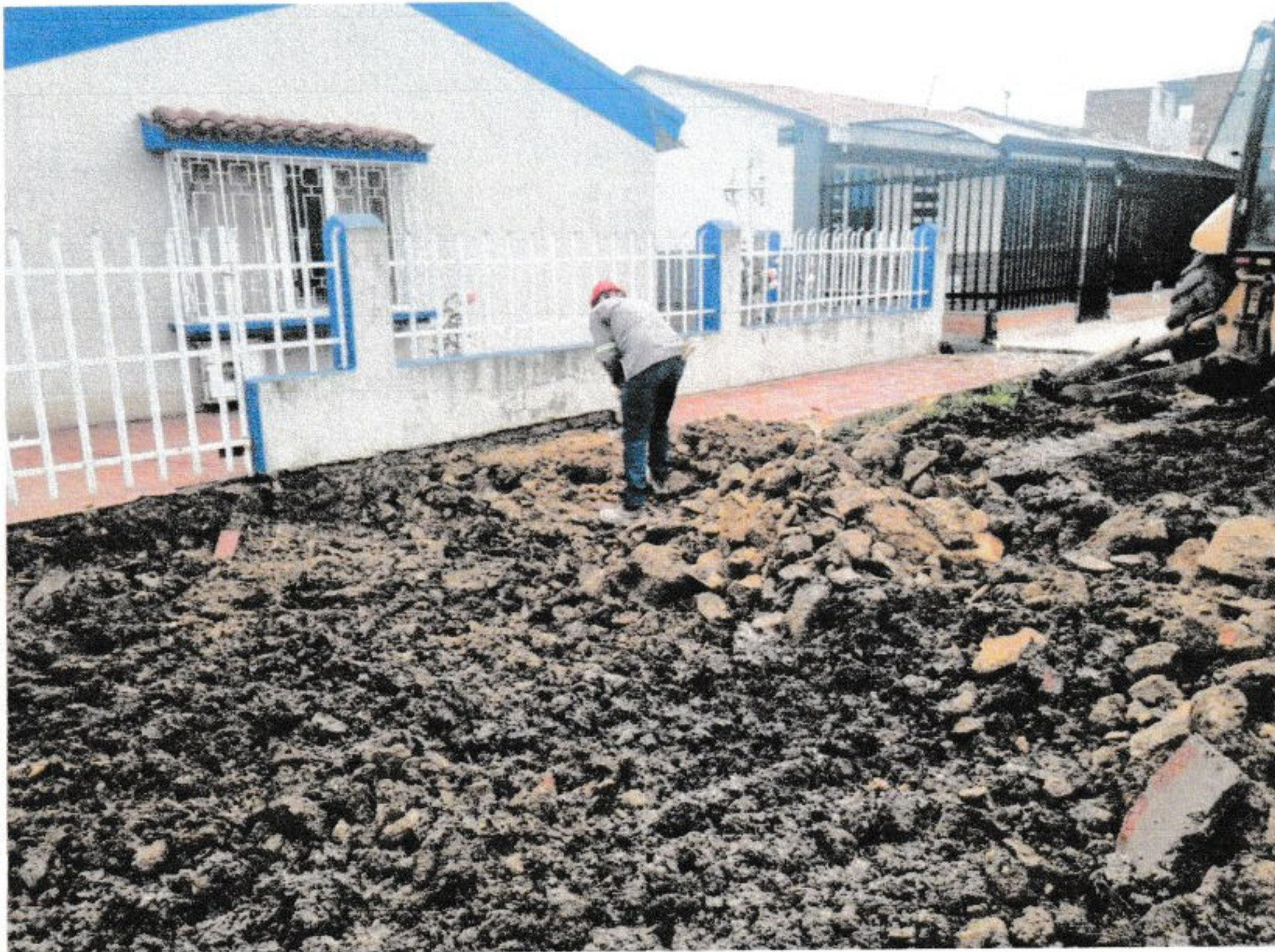
Imagen 6: Evidencia Fotográfica descapote manual – Fuente: Residente de Obra
