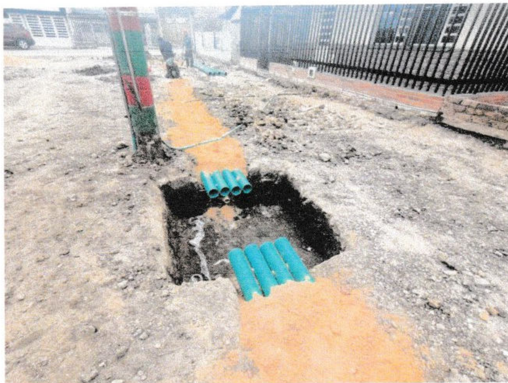
Imagen 23: Evidencia Fotográfica ducteria eléctrica 4 pulg – Fuente: Residente de Obra
