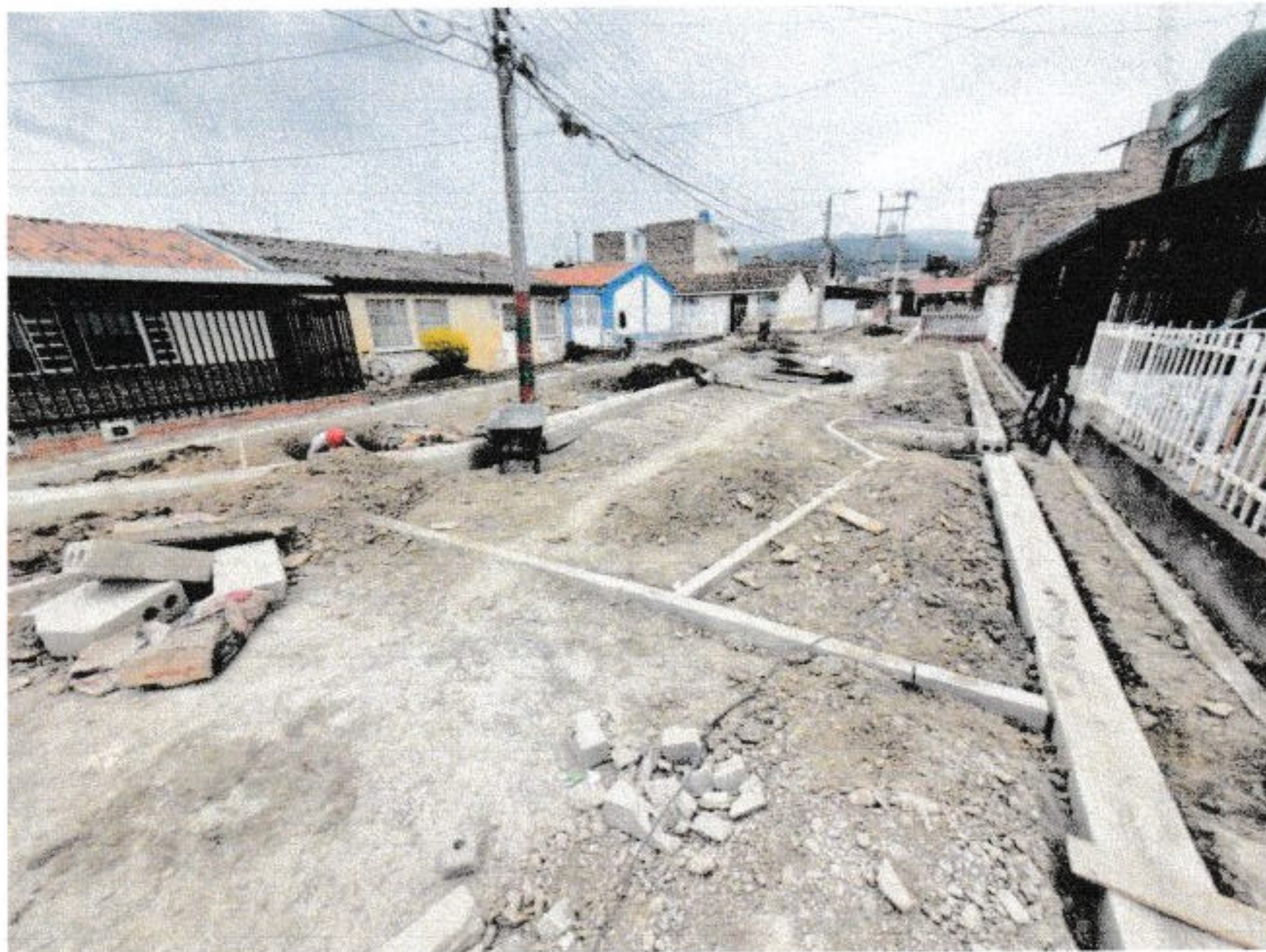
Imagen 13: Evidencia Fotográfica Instalación sardinel A 50 – Fuente: Residente de Obra
