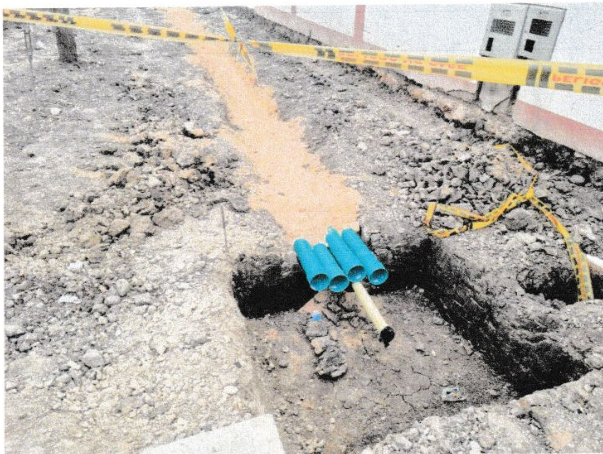
Imagen 27: Evidencia Fotográfica tubería 2 pulg desagüe – Fuente: Residente de Obra
