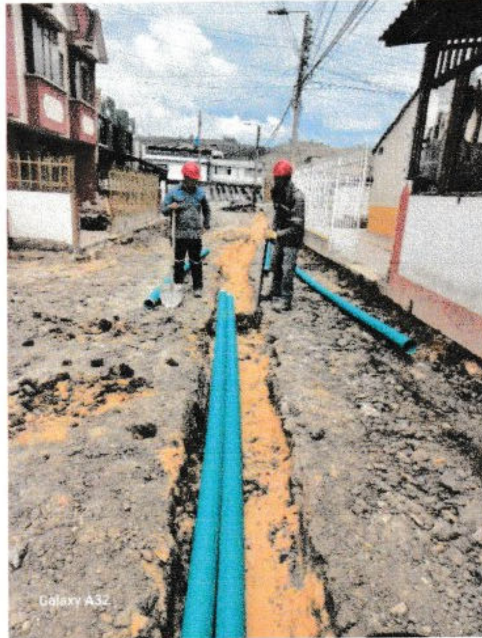
Imagen 19: Evidencia Fotográfica Excavación mecánica redes – Fuente: Residente de Obra
