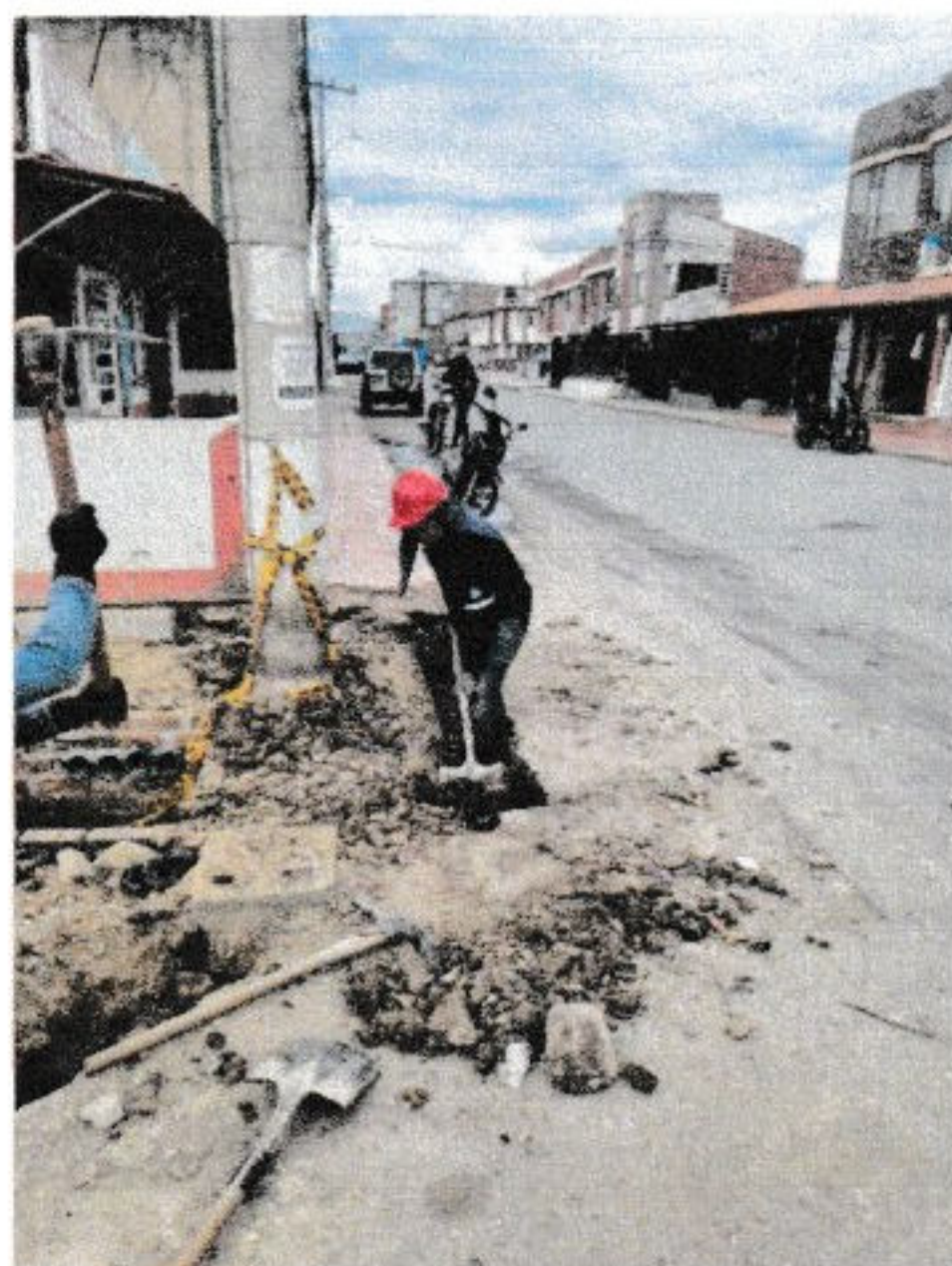
Imagen 8: Evidencia Fotográfica Demolición sardinel – Fuente: Residente de Obra
