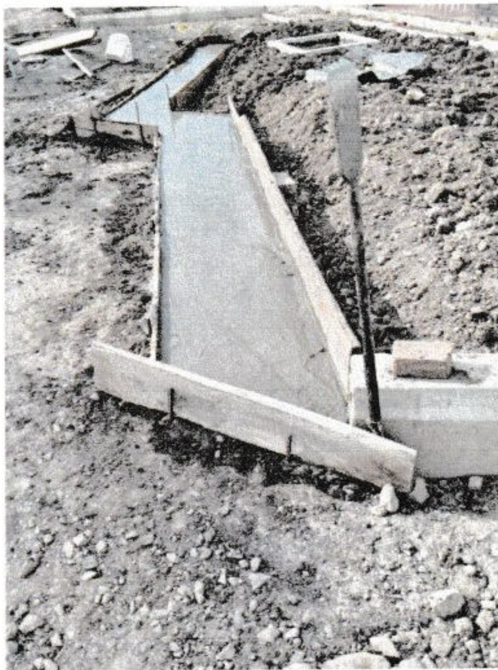
Imagen 10: Evidencia Fotográfica placas en concreto clase D – Fuente: Residente de Obra
