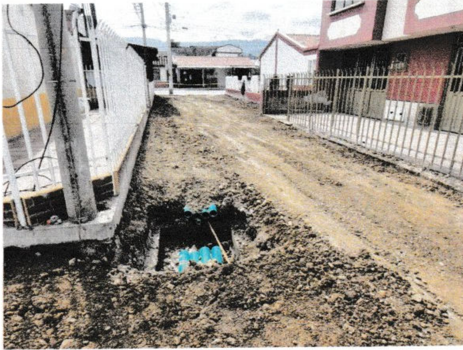
Imagen 21: Evidencia Fotográfica relleno material de excavación – Fuente: Residente de Obra
