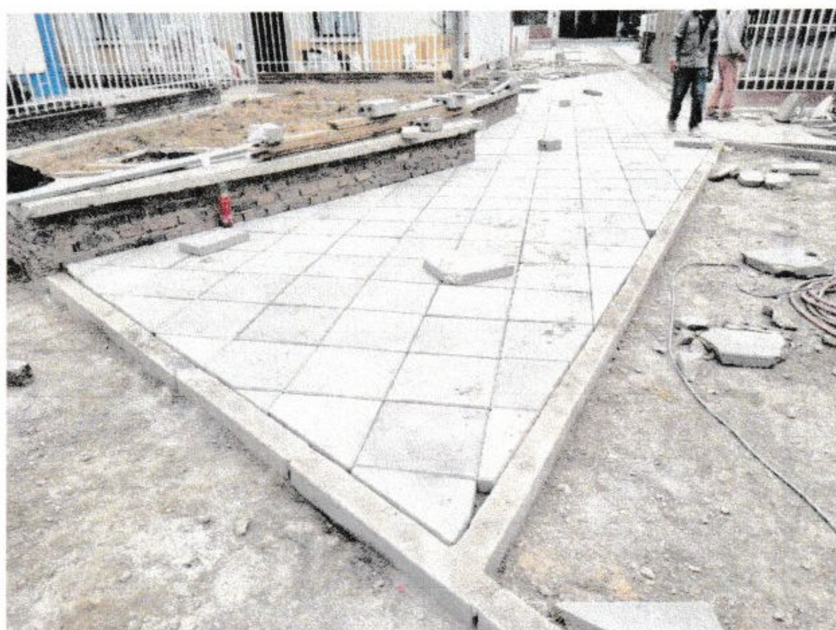
Imagen 13: Evidencia Fotográfica Instalación sardinel A 50 – Fuente: Residente de Obra
