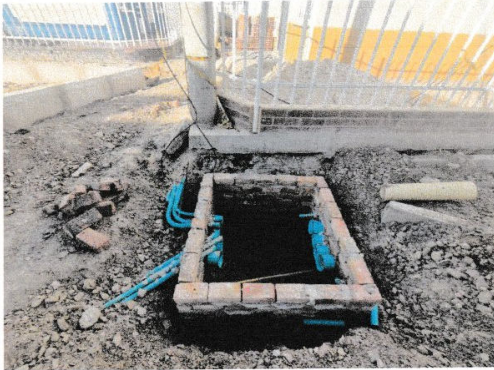
Imagen 25: Evidencia Fotográfica ducteria eléctrica 3/4 pulg – Fuente: Residente de Obra
