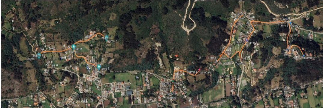
Figura 1. Localización general del proyecto (Fuente: Google Earth)
