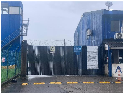
ACCESO ACTUAL DE ALFA 13
