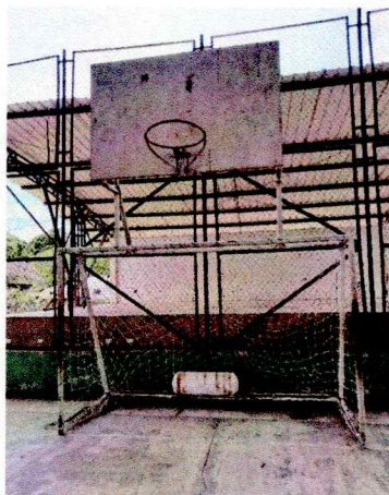
Fotografía 3. Tablero de baloncesto con superficie deteriorada, manchas y pérdida de pintura; aro con corrosión y sin red. En la parte inferior, arco de microfútbol con recubrimiento desgastado y oxidación en la estructura.
