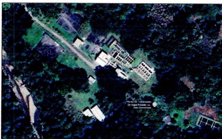
Figura 5. Planta de tratamiento de agua potable
