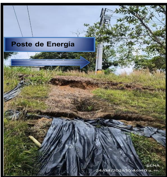
Foto 3: Erosión y desprendimiento.
