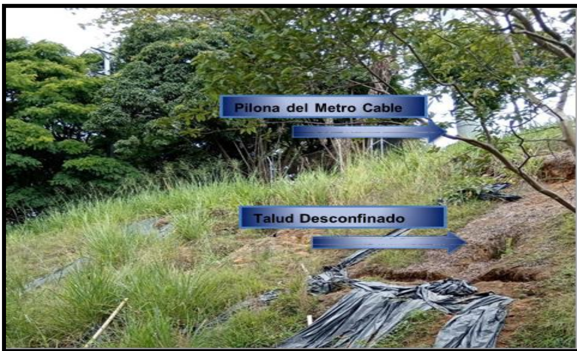
Foto 1: Talud desconfinado.
