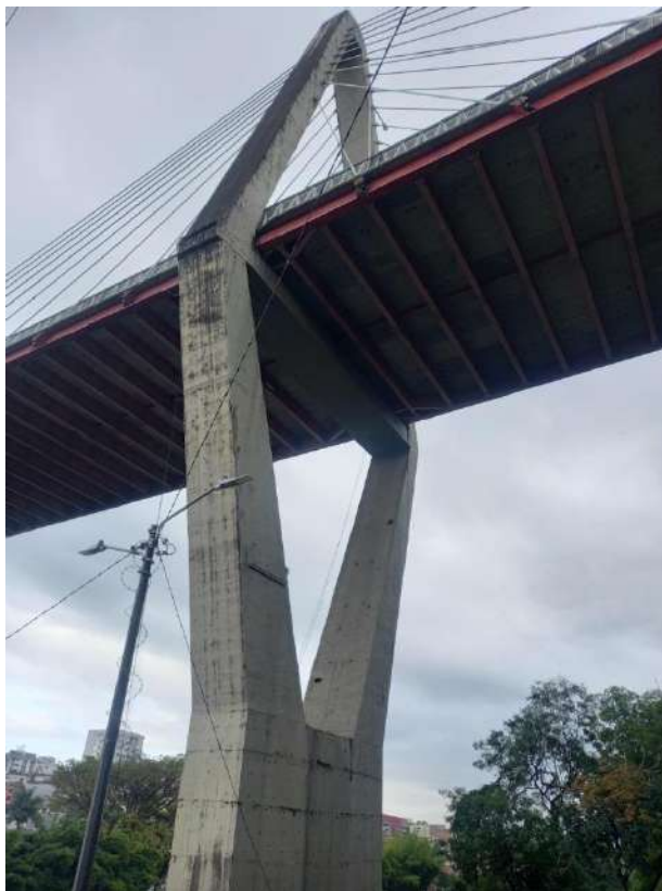
Fotografía No 4: detalle pila Dosquebradas
