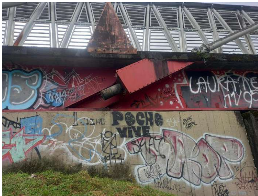
Fotografía No 11: estado de estribo y anclaje Dosquebradas
