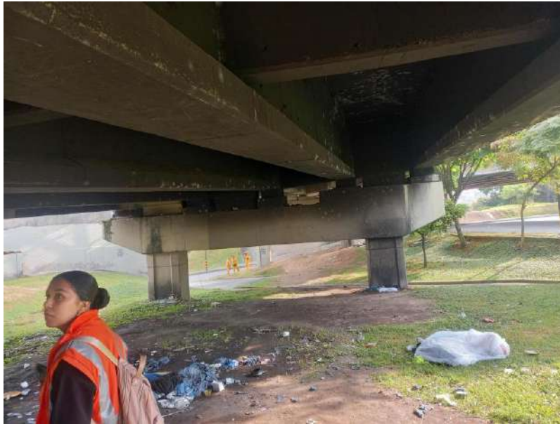
Fotografía No 16: vista inferior vigas y apoyo puente auxiliar de acceso al viaducto
