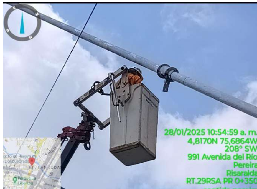
Fotografía No 22: vista inferior de inspección a sector de brida
