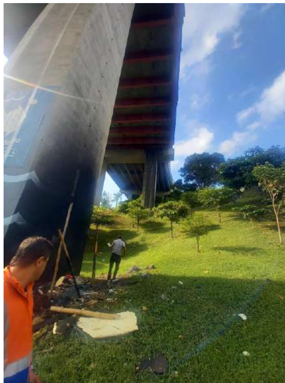
Fotografía No 18: vista inferior puente de acceso al viaducto Pereira: vigas y pórticos
