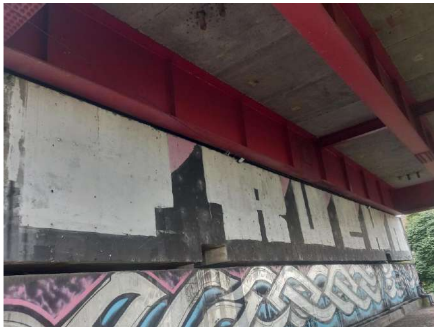
Fotografía No 10: estribo del viaducto Dosquebradas en estado aceptable
