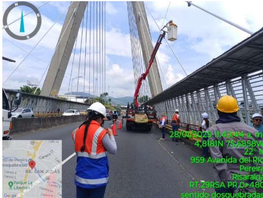
Fotografía No 20: equipo para llevar a cabo la inspección en altura
