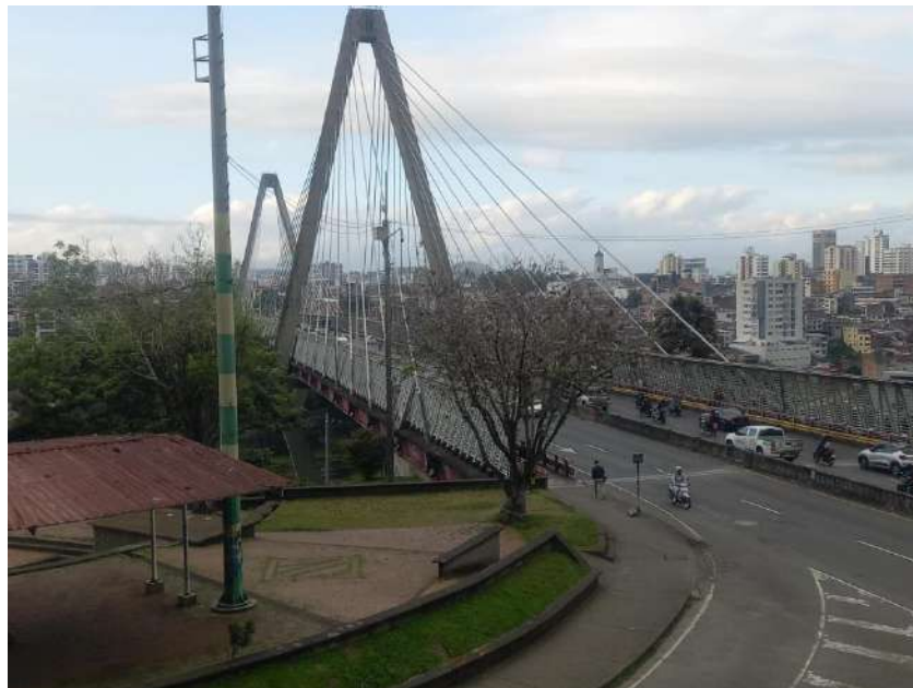
Fotografía No 1: vista general del viaducto desde Dosquebradas
