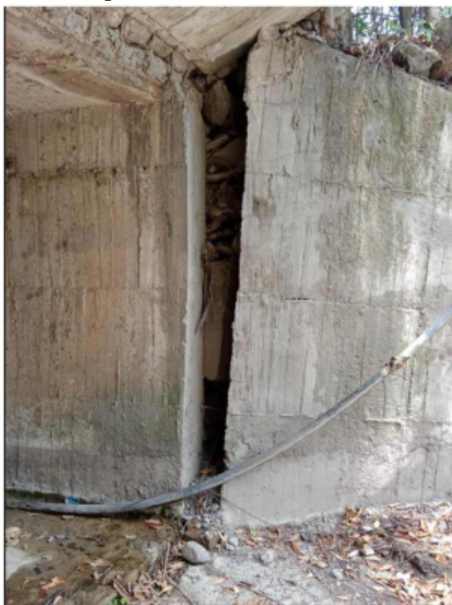
Imagen No. 2 estado del box coulvert.
