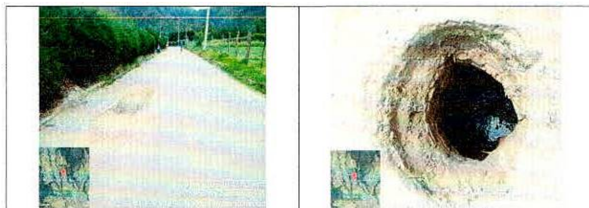
Figura 3. Registro fotográfico Visita de Campo reposición de alcantarillado
