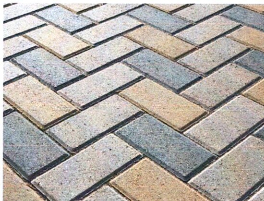
Ilustración 18 piso en adoquín concreto
