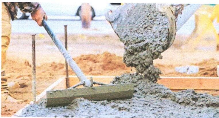
Ilustración 7. Concreto de 2500 psi para solado
