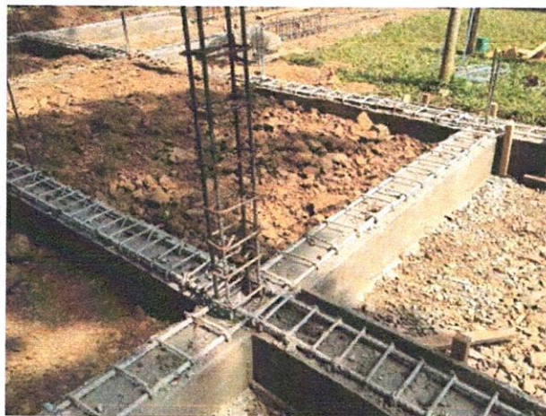
Ilustración 8. Viga de cimentación
