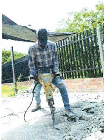
Ilustración 3 Demolición de losetas en concreto
