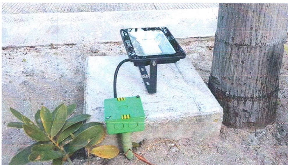
Ilustración 24 suministro e instalación de reflector en piso
