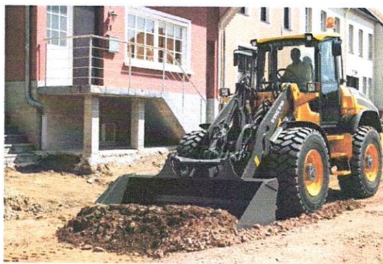
Ilustración 6 excavación mecánica cargue y disposición final de material
