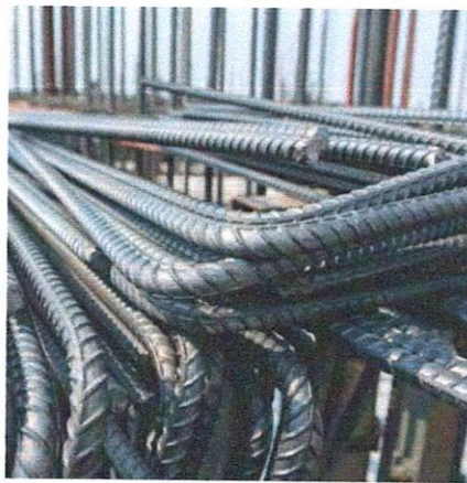
Ilustración 13. Acero de refuerzo f_y: 60000 \text{ psi}
